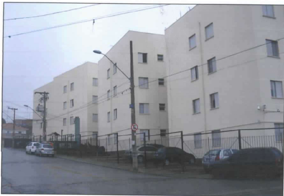
Foto 02- Vista das fachadas do blocos.
