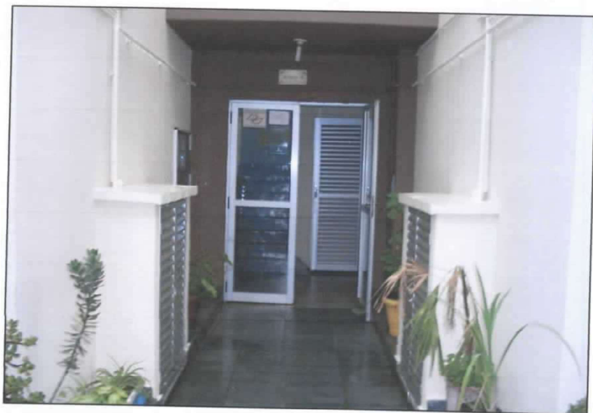
Foto 03- Vista da entrada do bloco 2.
