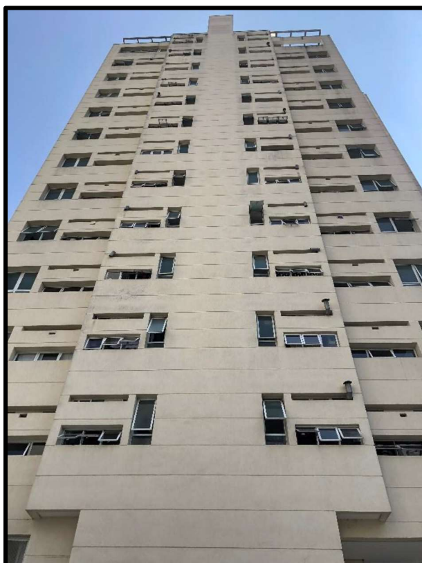
Foto 5: Fachada interna do edifício
