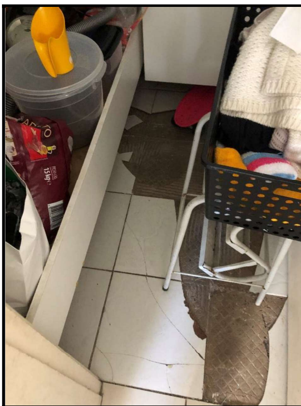
Foto 20: Detalhe, piso do quarto de Serviço
