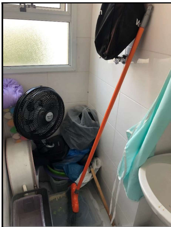
Foto 21: Banheiro de Serviço
