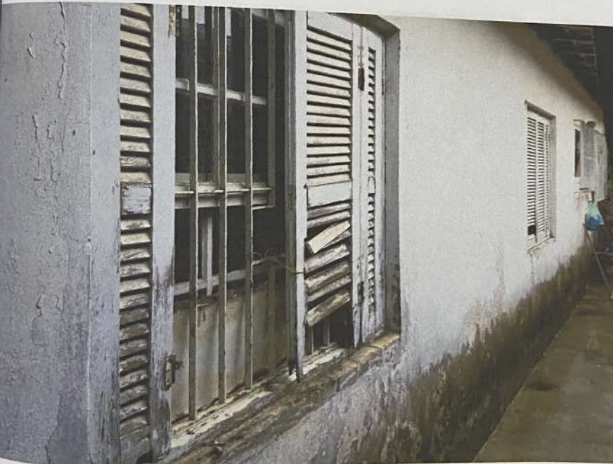
Foto 16 - Parede externa dos dormitórios (janelas dos dormitórios 2 e 1)
