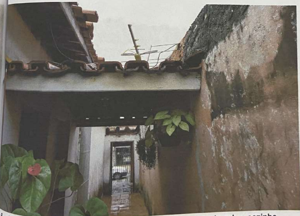
Foto 6 - Corredor lateral com detalhe da cobertura nas portas da sala e cozinha
