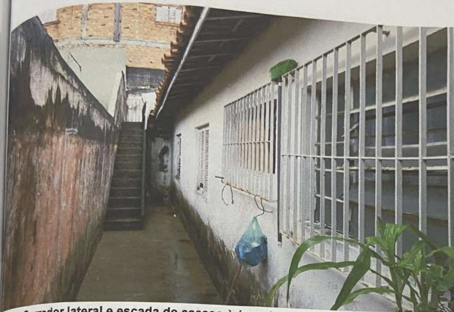
Foto 5 - Corredor lateral e escada de acesso à área de serviço
