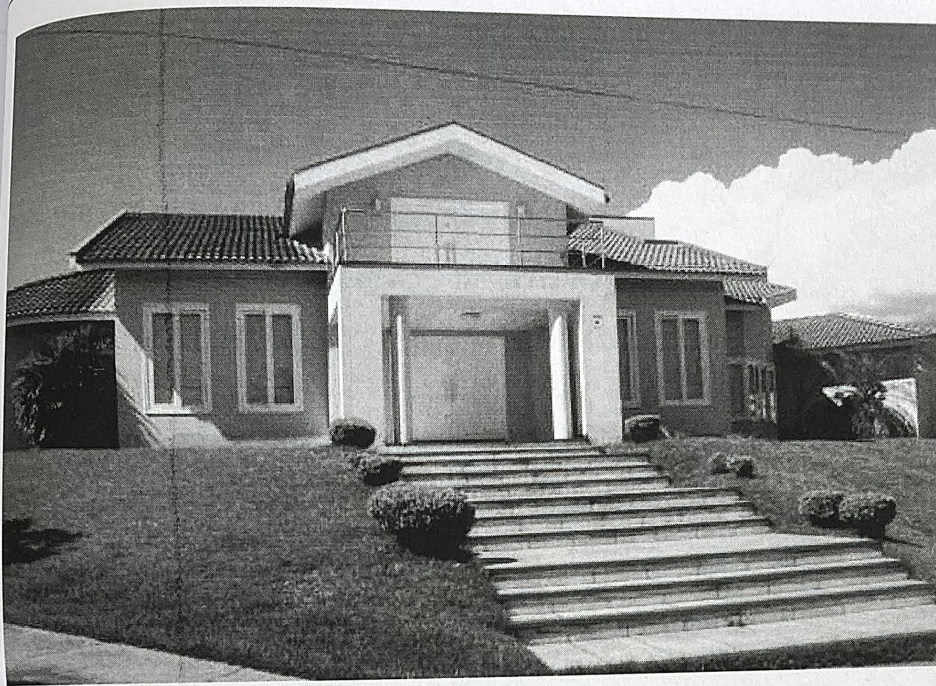
Foto 03: Vista do imóvel.
