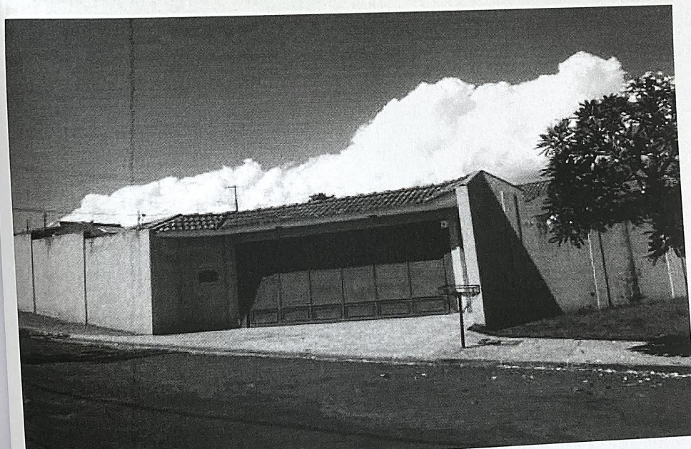
Foto 04: Entrada da garagem pela Rua Macapá.
