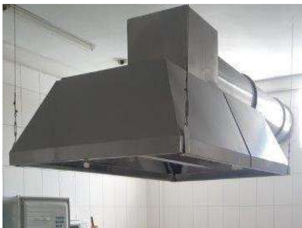
DETALHES COIFA IND. INOX (REFEITÓRIO - TÉRREO)
