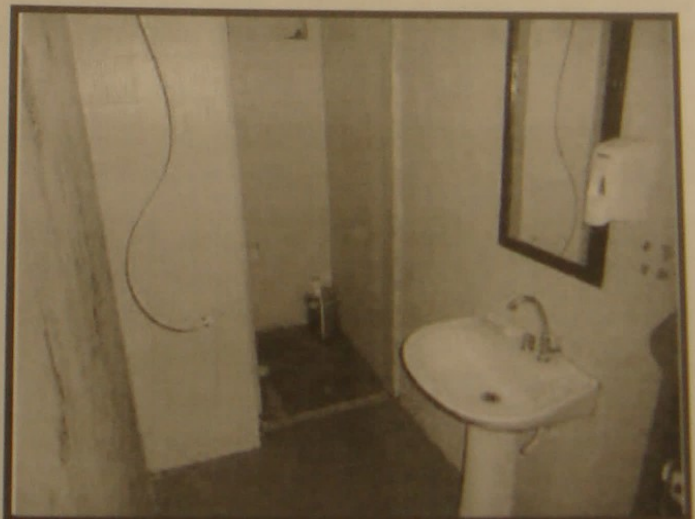
Foto 15 Banheiro de Funcionários
