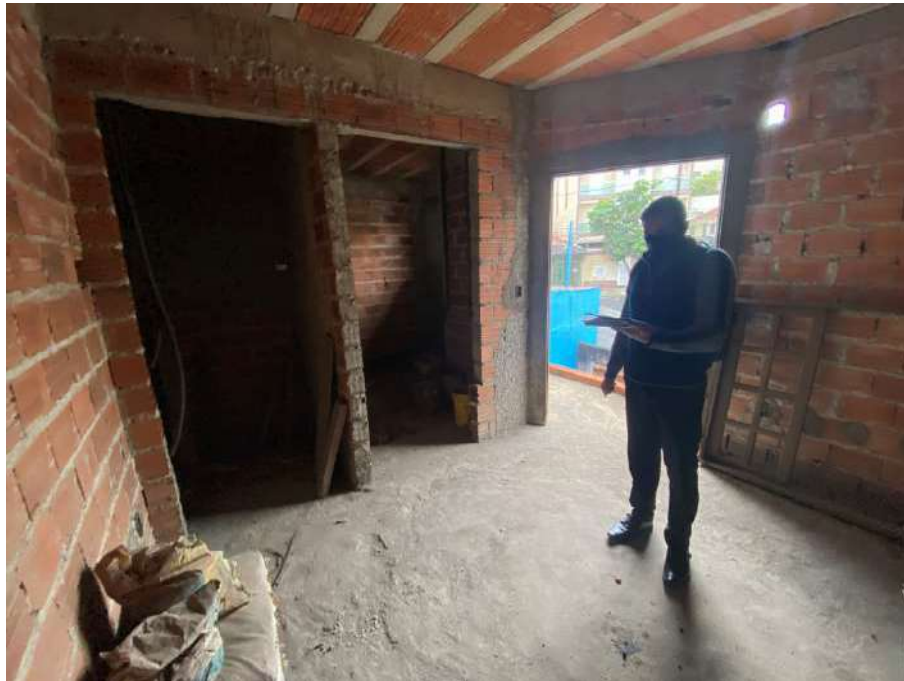
VISTA DO DORMITÓRIO.
