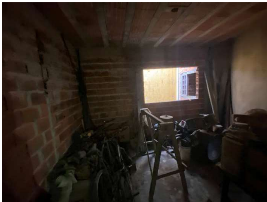
VISTA DO DORMITÓRIO.
