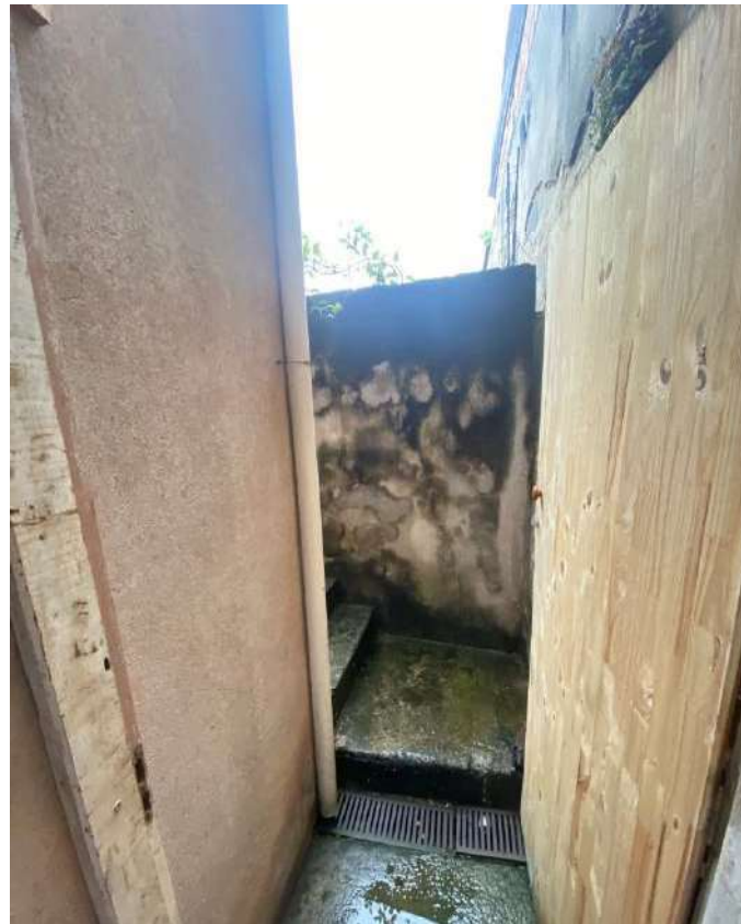
VISTA DA ESCADA DE ACESSO AO PAVIMENTO SUPERIOR.
