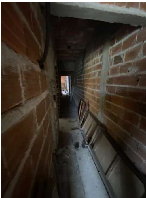
VISTA DO CORREDOR.
