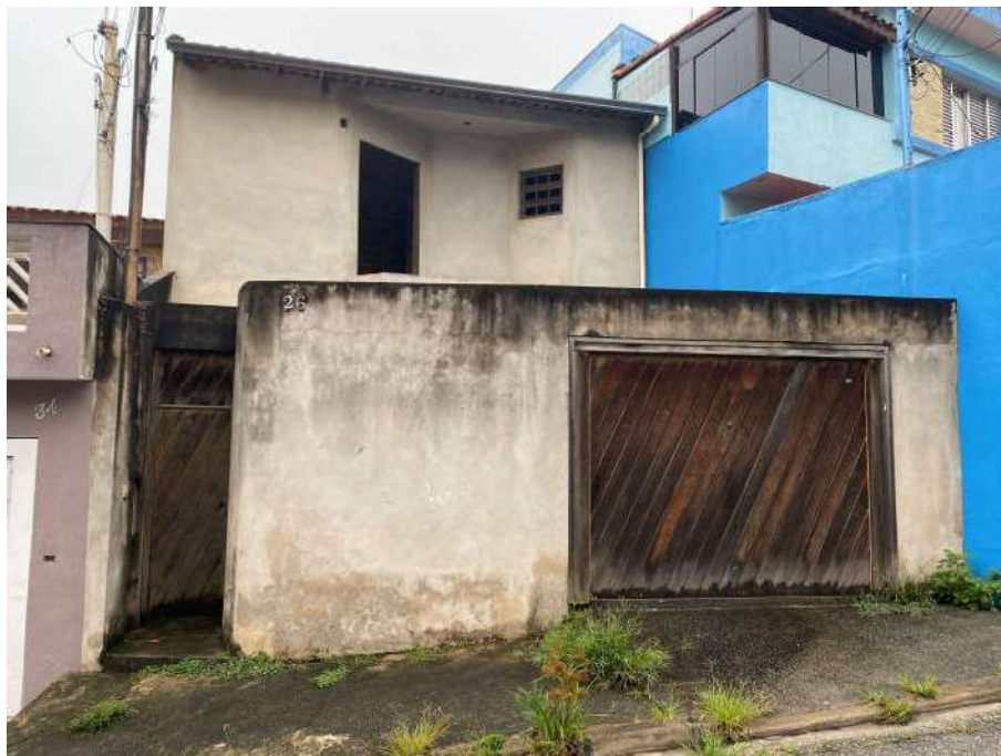
VISTA DA ENTRADA DO IMÓVEL.
