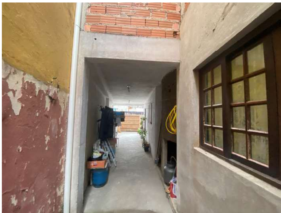
VISTA DO CORREDOR LATERAL.
