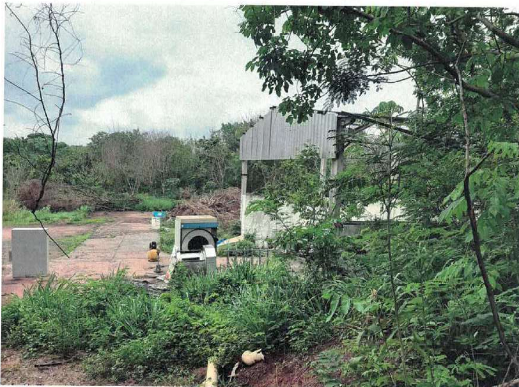
Vista do Imóvel Avaliando
