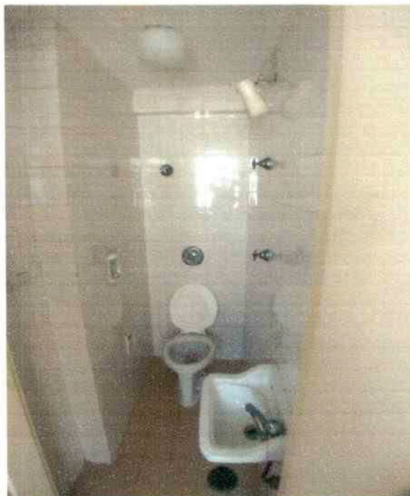
BANHEIRO DE SERVIÇO
