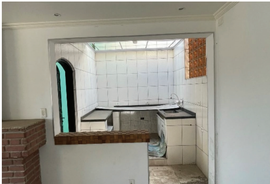
Foto 16 – Área de serviço – Apartamento 31 – 4º Pavimento – Avaliando
