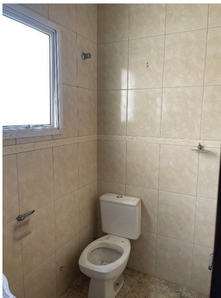
Foto 9 – Banheiro suíte 1 – Apartamento 31 – 3º Pavimento – Avaliando
