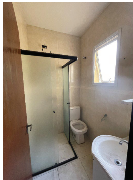
Foto 14 – banheiro – suíte 2 – Apartamento 31 – 3º Pavimento – Avaliando
