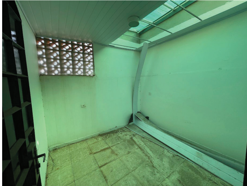
Foto 17 – Depósito – Apartamento 31 – 4º Pavimento – Avaliando
