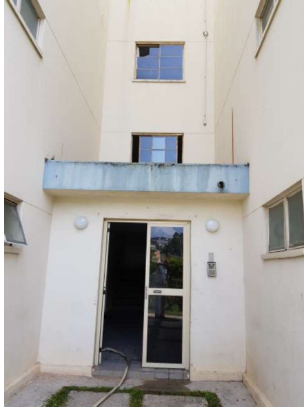
FOTO Nº 01 Vista parcial da fachada do Edifício Trancoso
