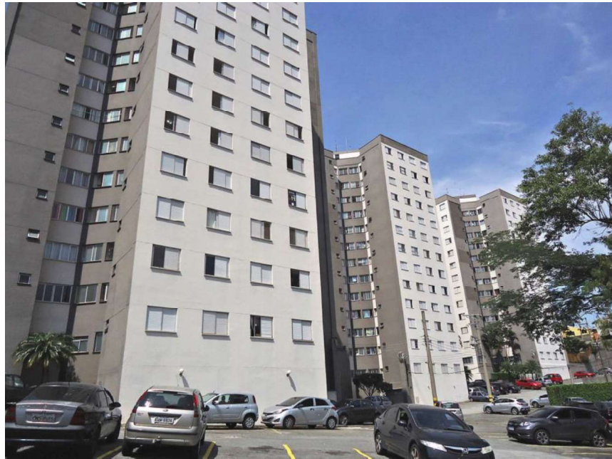
Vista do Fundo do Terreno - Blocos 1, 2 e 3
