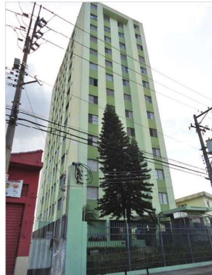
H. RUA RIO VERDE, 451 EDIFÍCIO MAI-SO
