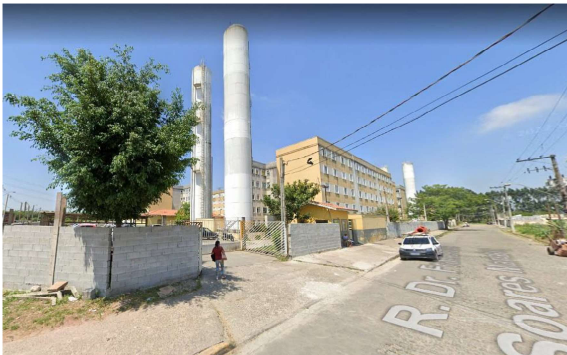
01. Fachada Principal do Condomínio.
