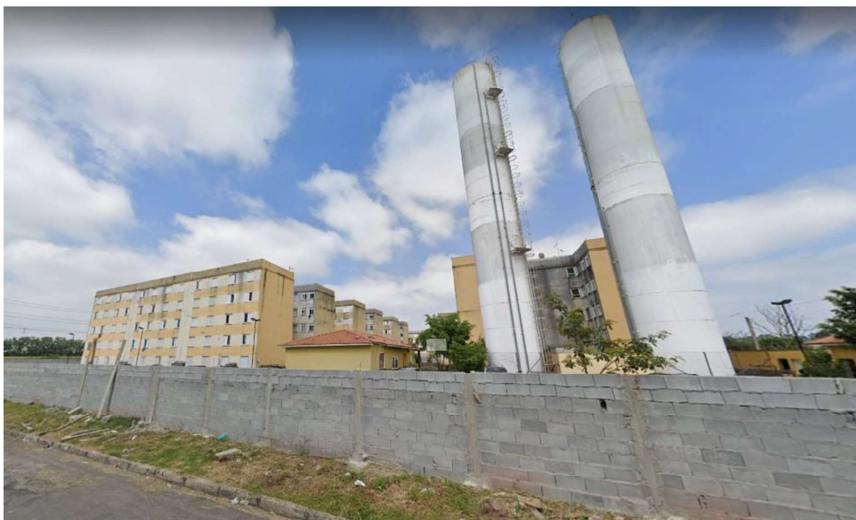
02. Fachada Lateral Esquerda do Condomínio.
