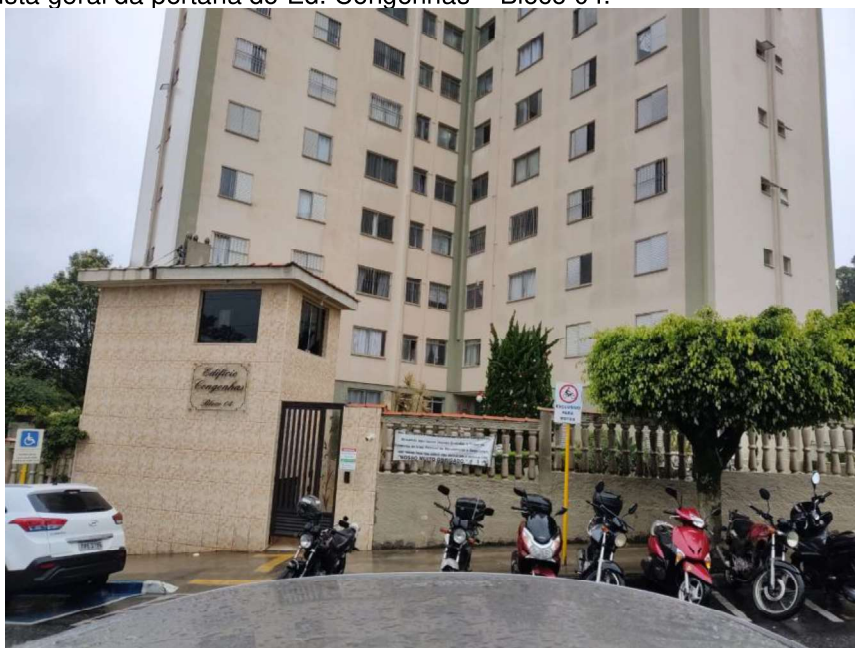
Foto 4 - Vista geral da portaria do Ed. Congonhas – Bloco 04.
