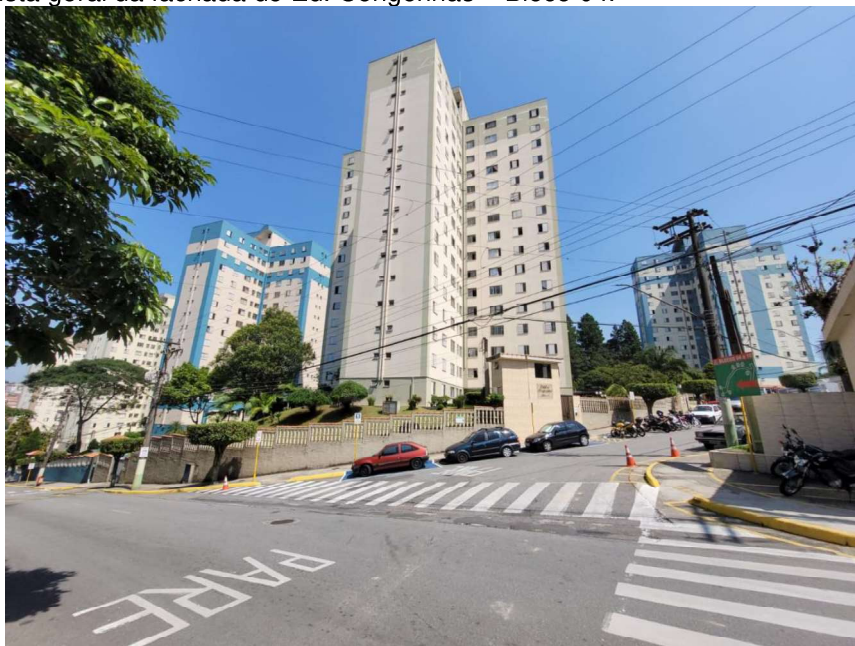
Foto 3 - Vista geral da fachada do Ed. Congonhas – Bloco 04.
