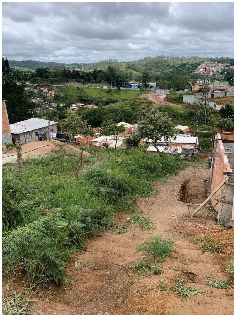
Foto nº. 8 – Outra vista interna do imóvel.
