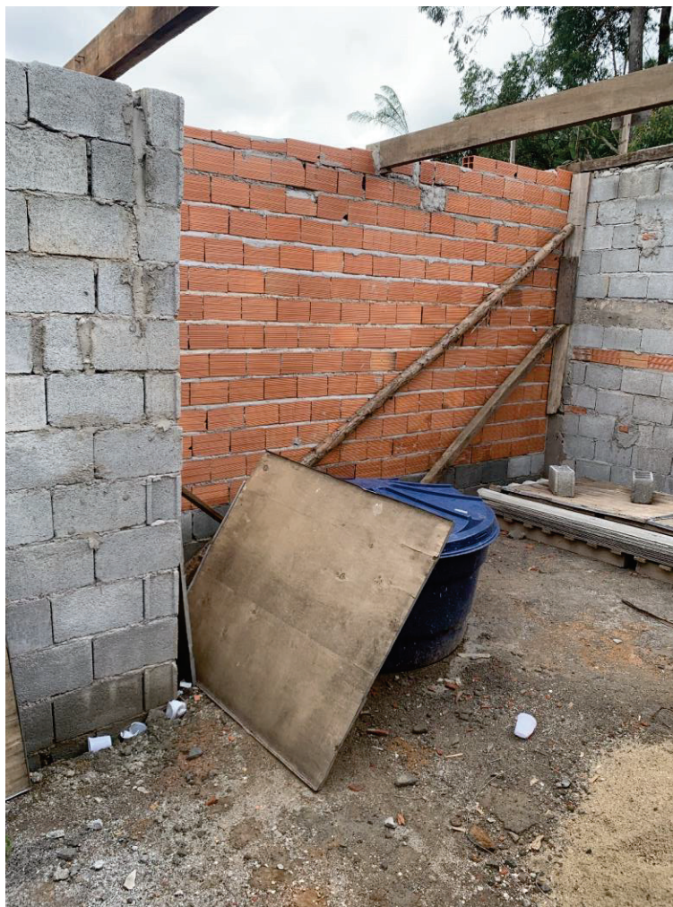
Foto n.º 11 – Vista interna da benfeitoria.
