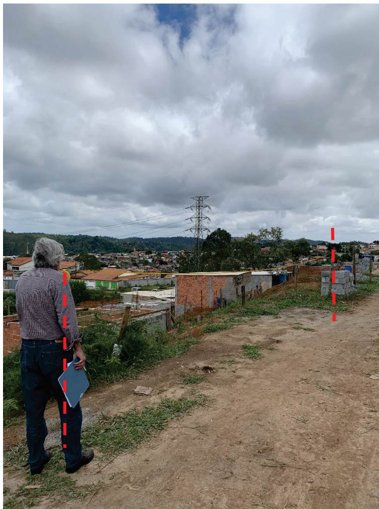
Foto nº. 4 – Outra vista da fachada.
