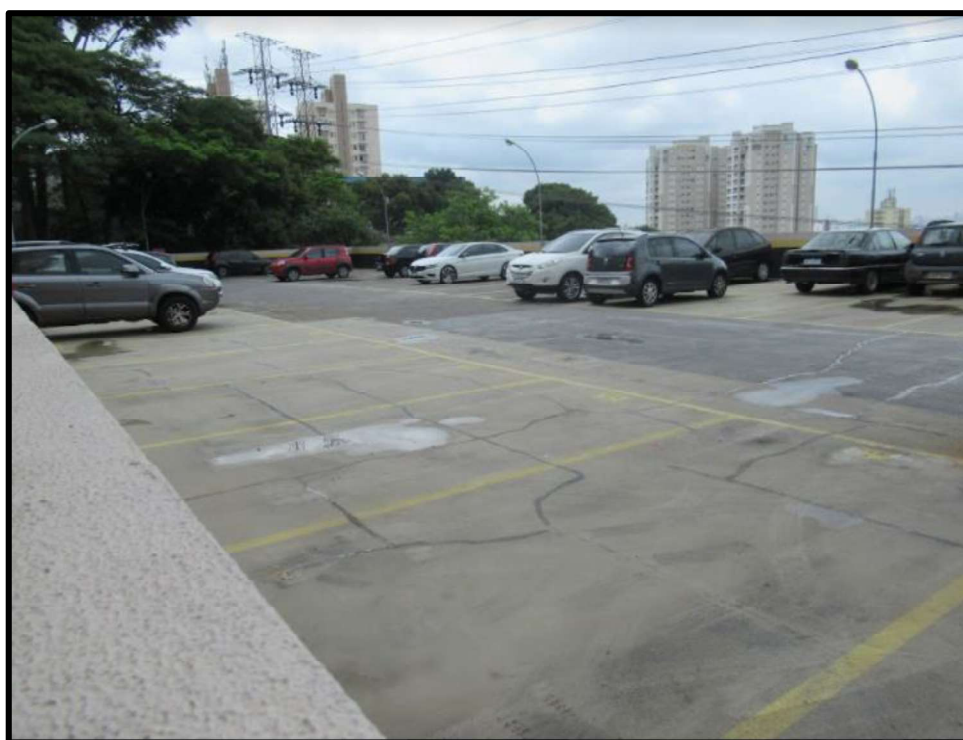
Foto 24: Vista do estacionamento
