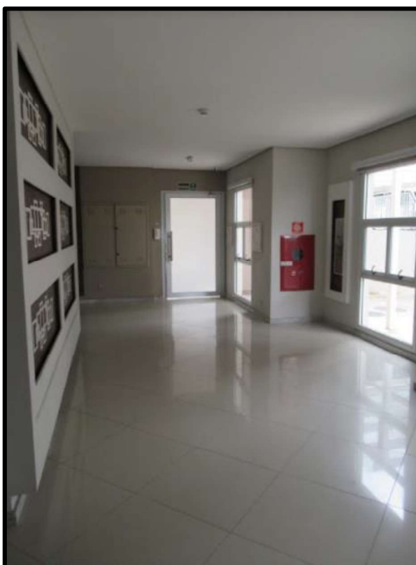
Foto 8: Hall de entrada da Torre 2 - Edifício Tóquio
