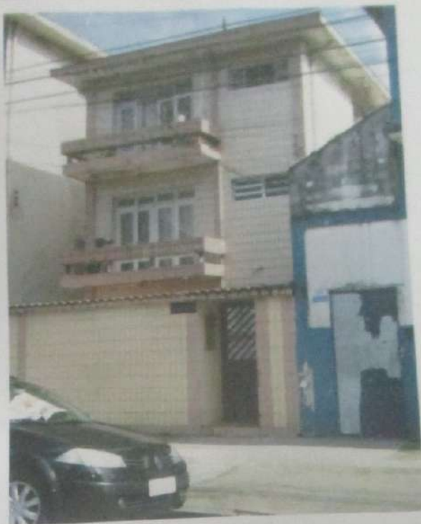
FOTO 02: -Vista do prédio.
