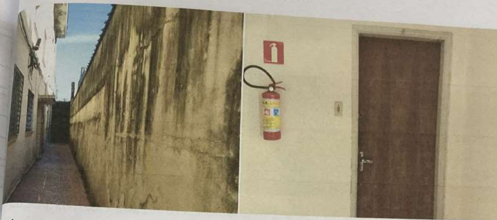
(s da Lateral de Acesso ao Apartamento e da Porta de Entrada do mesmo)
