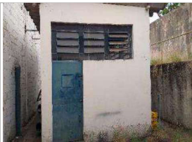
Casa de maquinas 01
