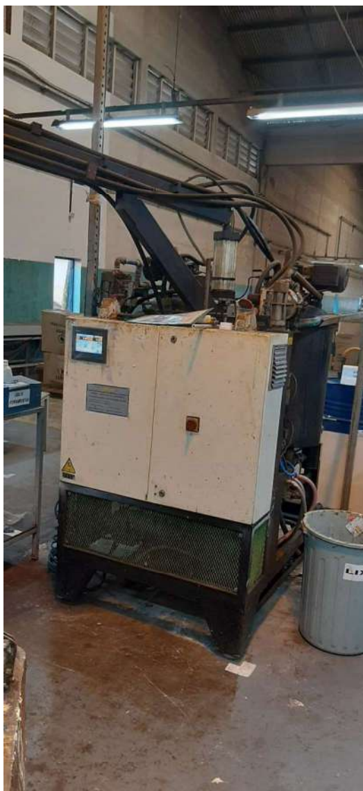
MÁQUINA DE INJEÇÃO COM TRANSFORMADOR SULPOL
