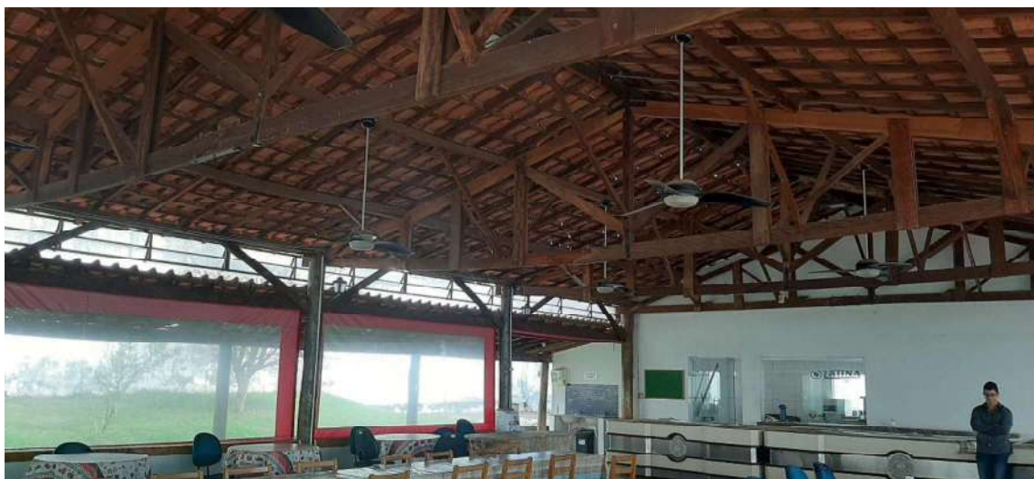
VENTILADORES DE TETO E BENS EXISTENTES NO REFEITÓRIO
