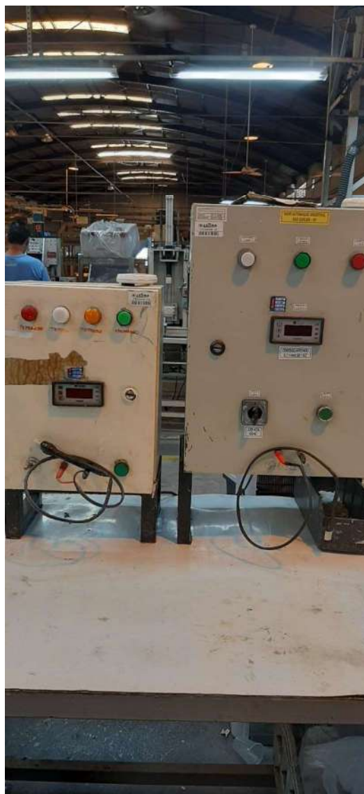
TESTE ELÉTRICO DE RESERVATÓRIO
