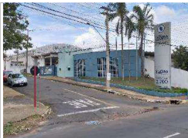
Fachada para a Rua José Jorge Saab – acesso ao imóvel
