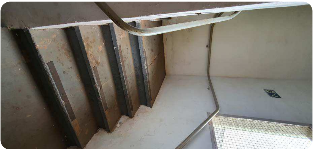
Escada de incêndio
