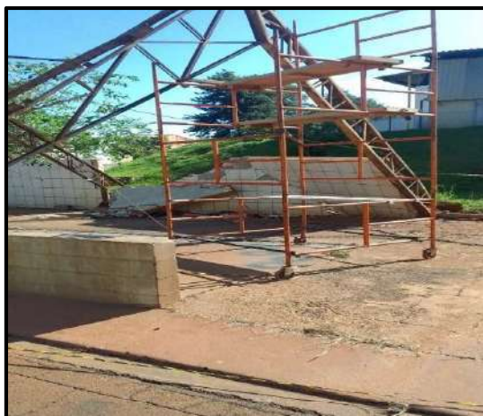
Andaime tipo plataforma
