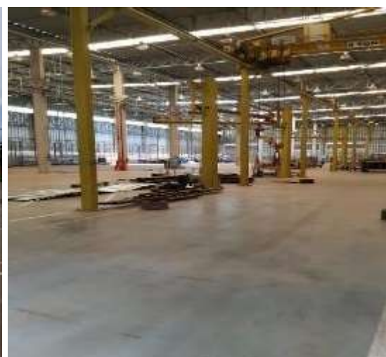
Panorama interno prédio 10
