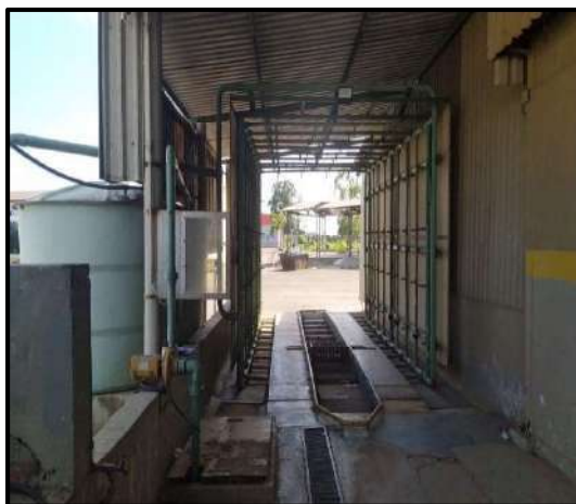
Teste de água em veículos
