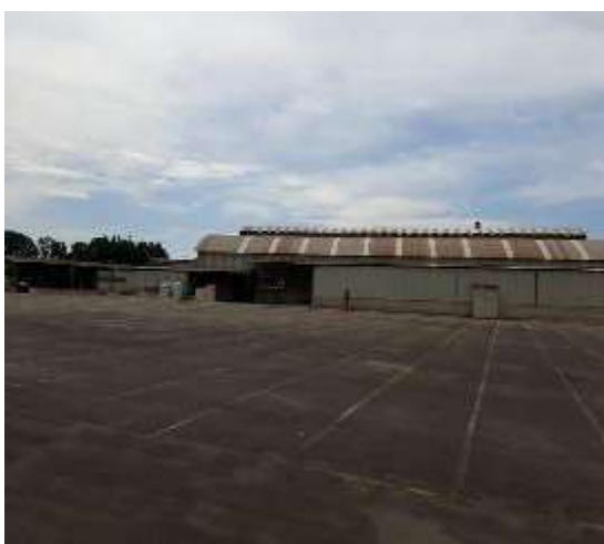
Panorama externo galpão 04
