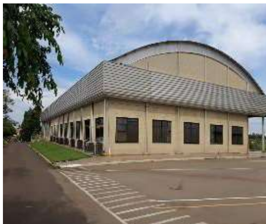
Panorama externo galpão refeição
