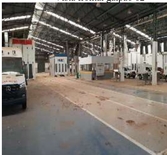
Panorama interno galpão 02
