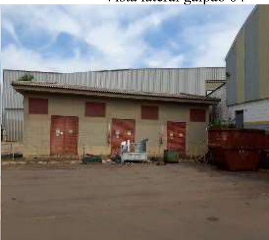
Vista casa de força
