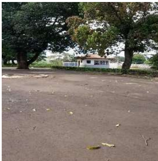
Vista portaria fundo
