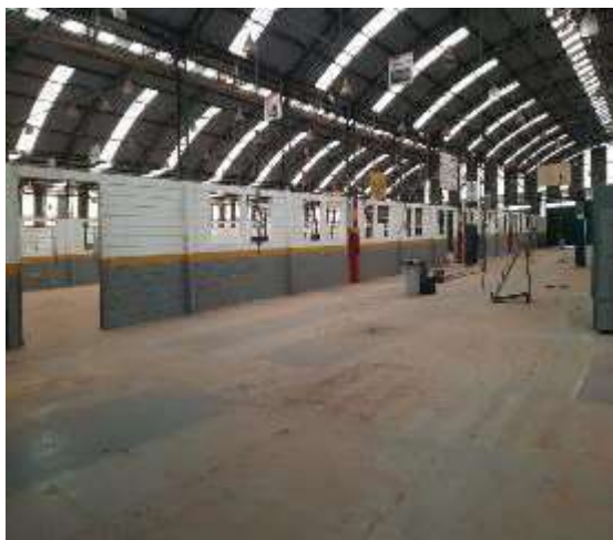
Panorama interno galpão 04
