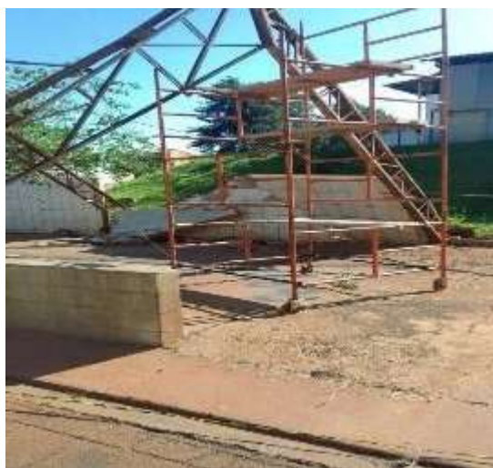
Andaime tipo plataforma
