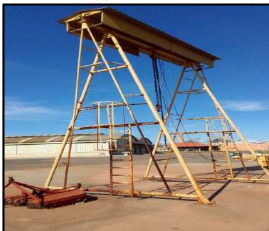
Pórtico com talha
