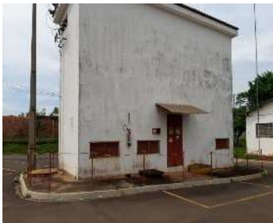
Vista casa de força
