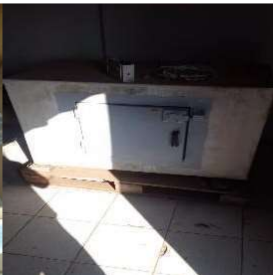
Cofre concreto com porta em aço
