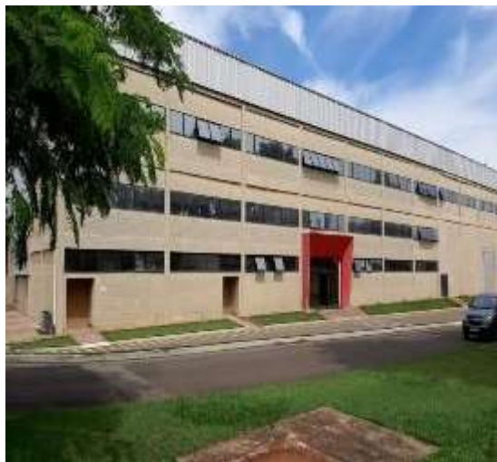
Panorama externo prédio 10
