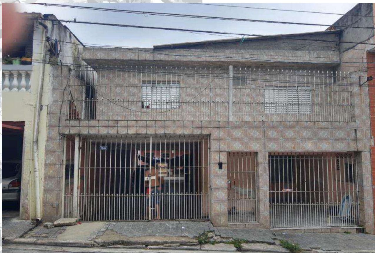
FACHADA DO IMÓVEL AVALIANDO
