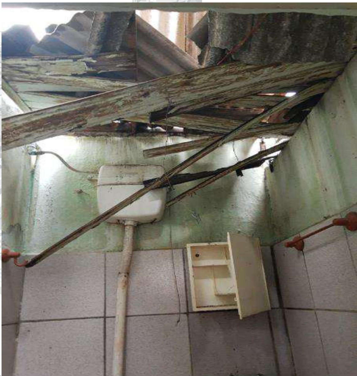
FOTO FORRO W.C FUNDOS
