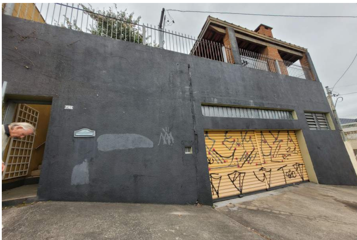
Imagem 30: Entrada da casa pela Rua Aurélia.
