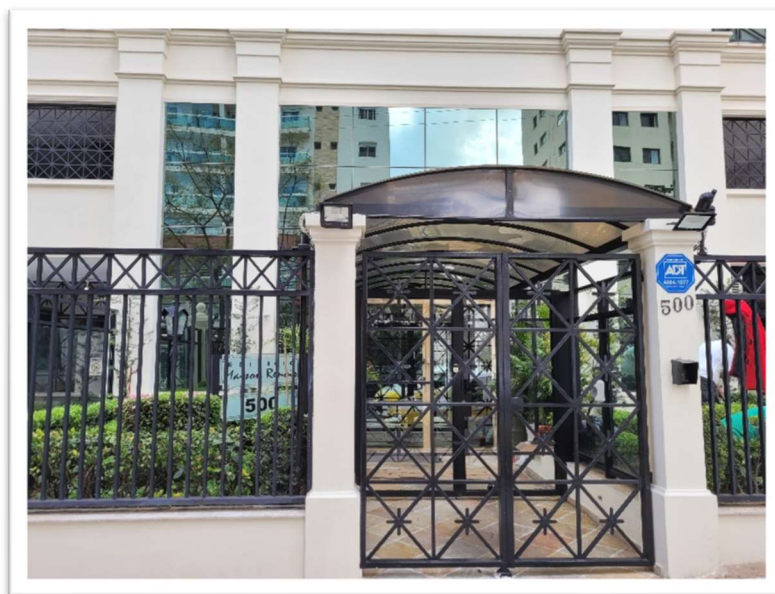
FOTO 01 – VISTA DA ENTRADA DO CONDOMÍNIO DO IMÓVEL AVALIANDO
