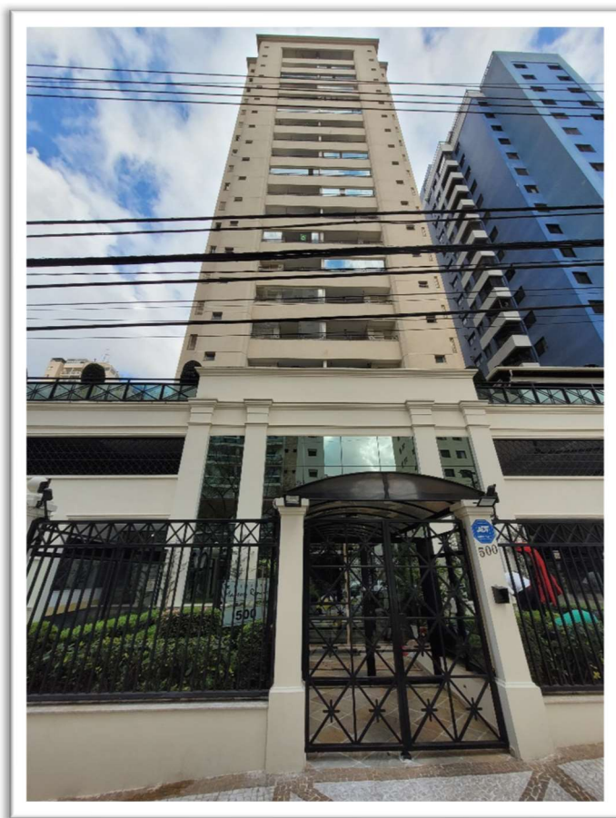
FRENTE DO EDIFÍCIO DO IMÓVEL AVALIANDO
