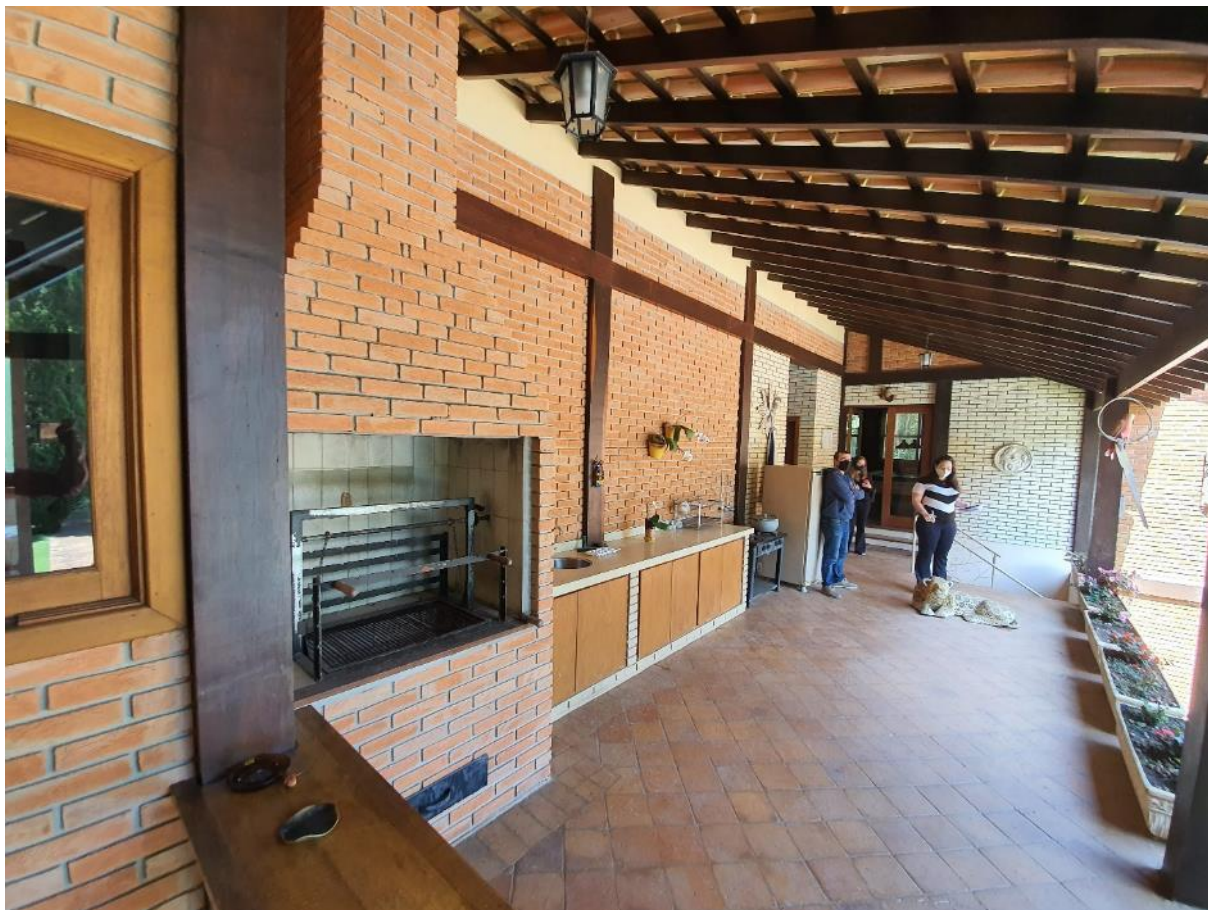
Foto 29: Vista geral da área da churrasqueira, observando-se seu padrão construtivo, acabamentos e estado de conservação.
