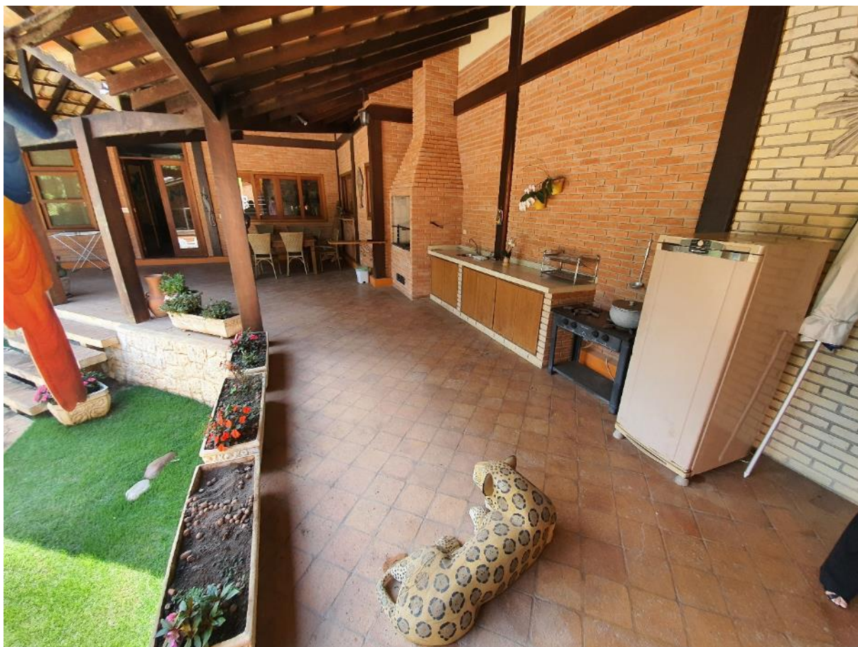
Foto 30: Vista geral da área da churrasqueira, observando-se seu padrão construtivo, acabamentos e estado de conservação.
