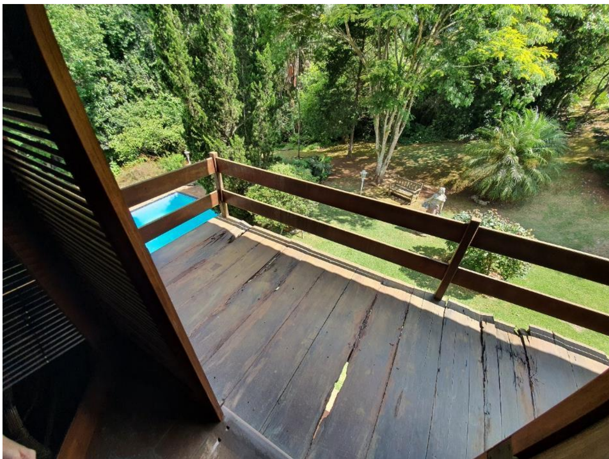
Foto 40: Vista da sacada da suíte 1, localizada no pavimento superior do imóvel avaliando, observando-se seu padrão construtivo, acabamentos e estado de conservação.
