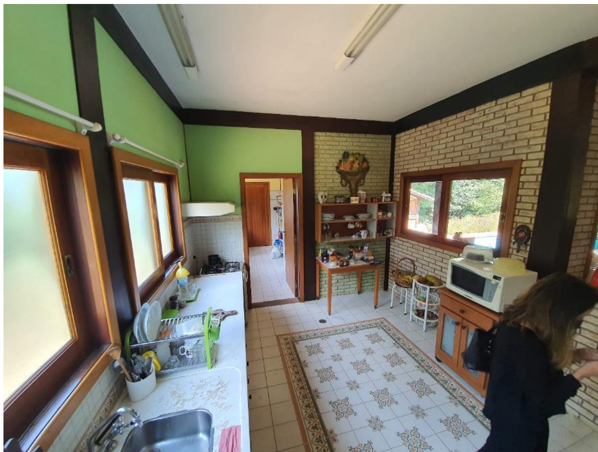
Foto 21: Vista da cozinha, localizada no pavimento térreo do imóvel avaliando, observando-se seu padrão construtivo, acabamentos e estado de conservação.
