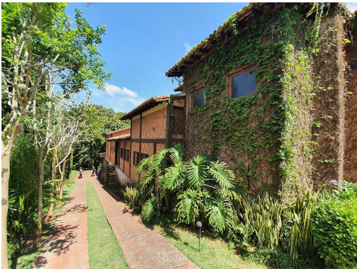
Foto 6: Vista do acesso de veículos e da fachada lateral esquerda do imóvel avaliando.
