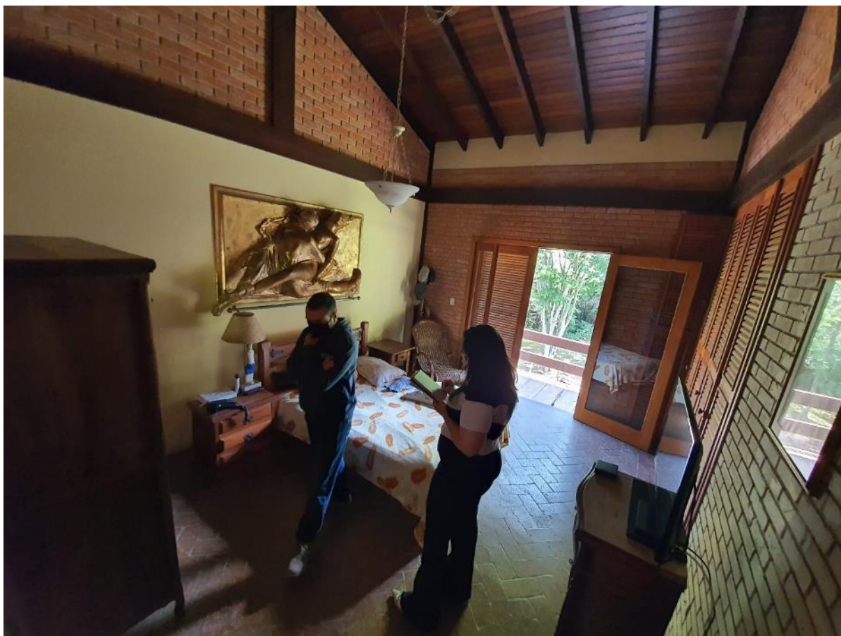
Foto 38: Vista do dormitório da suíte 1, localizado no pavimento superior do imóvel avaliando, observando-se seu padrão construtivo, acabamentos e estado de conservação.
