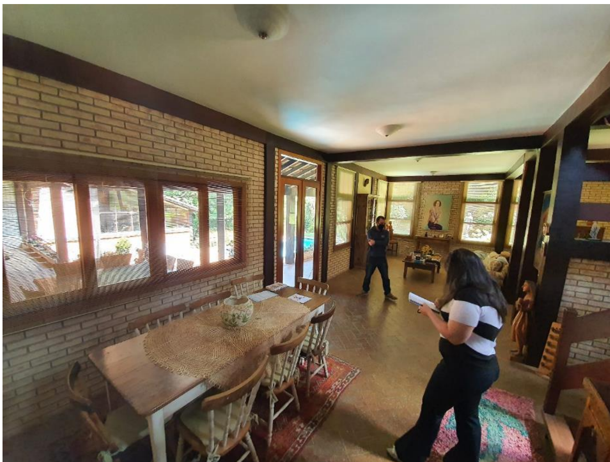
Foto 15: Vista da sala de jantar do imóvel avaliando, observando-se seu padrão construtivo, acabamentos e estado de conservação.
