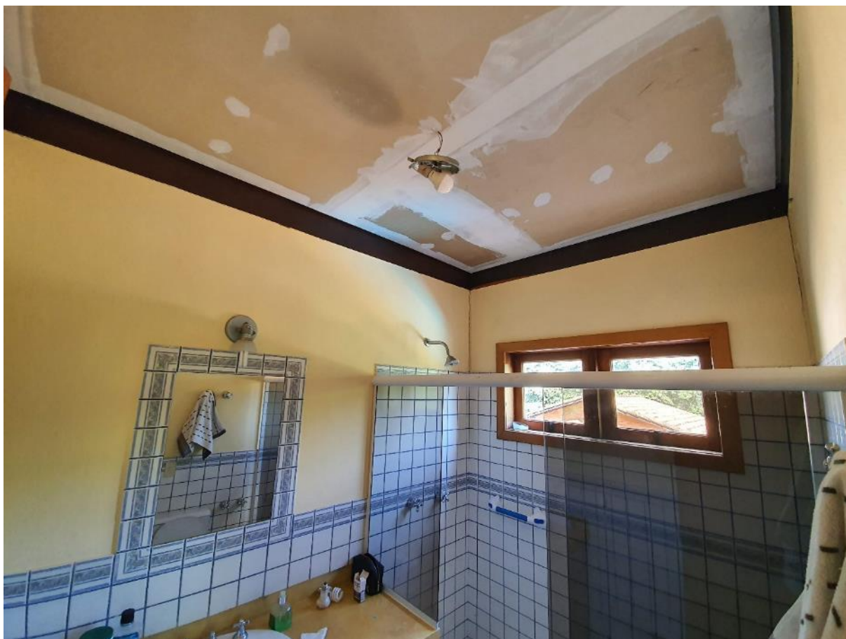
Foto 43: Vista do banheiro da suíte 1, localizado no pavimento superior do imóvel avaliando, observando-se seu padrão construtivo, acabamentos e estado de conservação.
