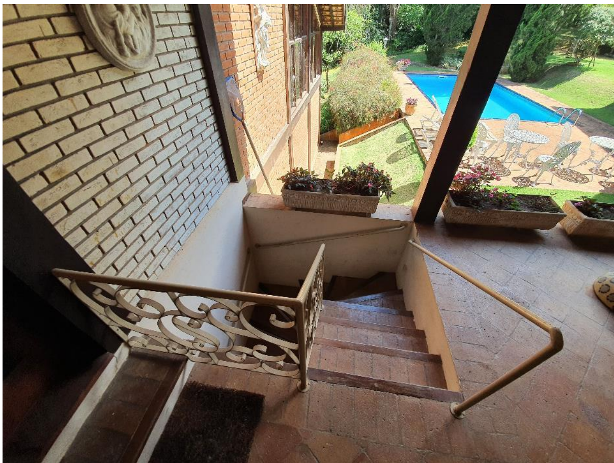
Foto 32: Vista das escadas de acesso à garagem do imóvel avaliando.
