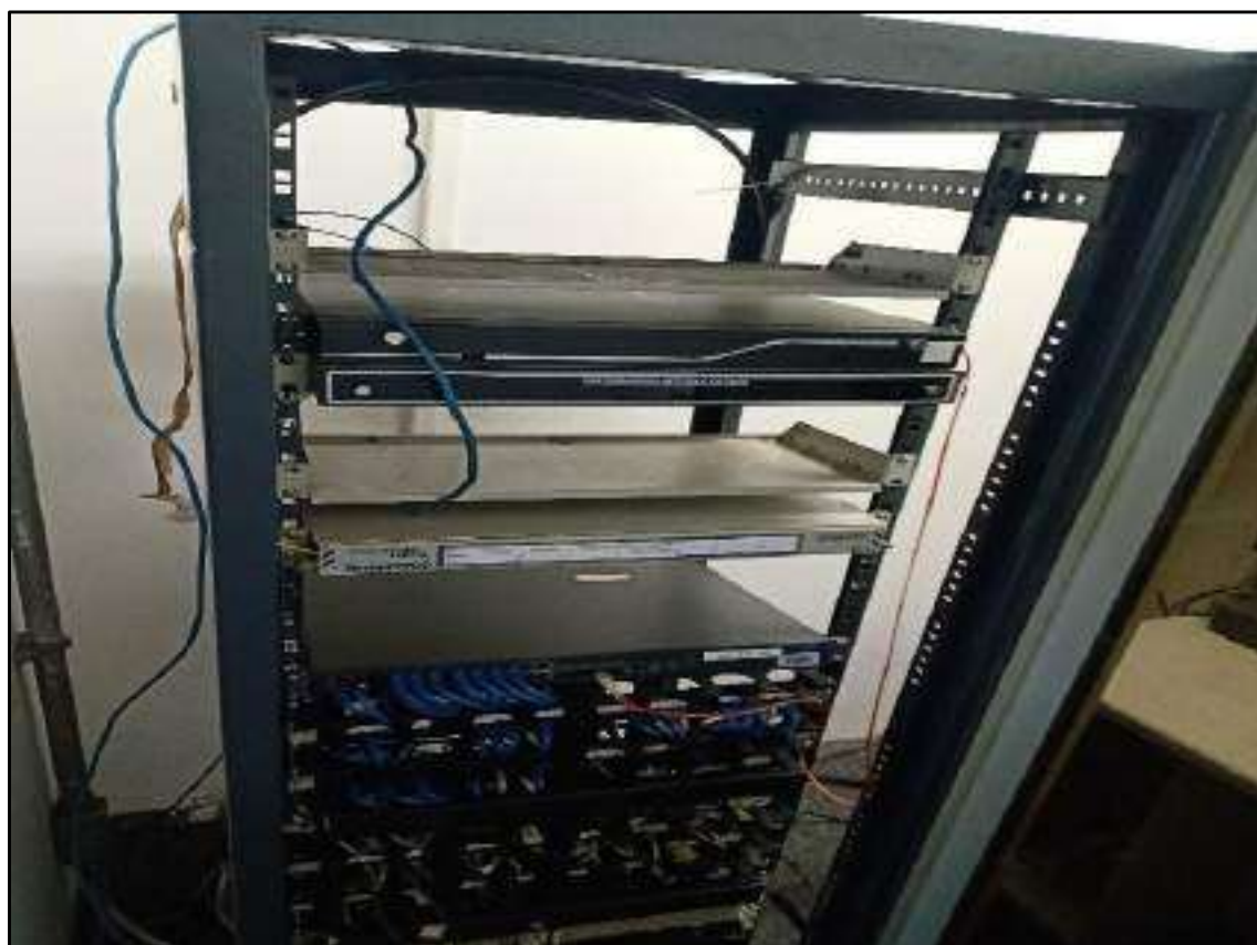
ITEM 0084 - RACK ORGANIZADOR COM 1 SWITCH E 3 DISTRIBUIDOR DE FIBRA OPTICA COD: SP086
