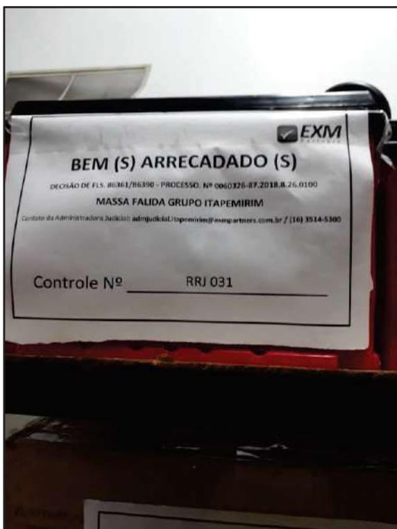
ITEM 0213 - CONJUNTO DE 16 BATERIAS FREEDOM COD.:RRJ031
