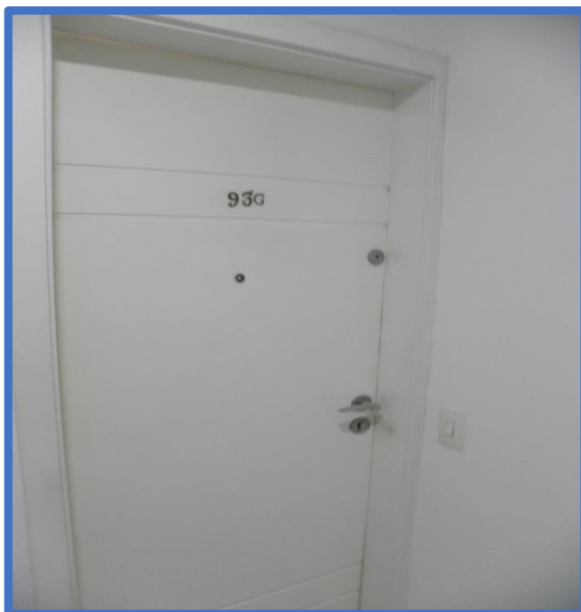
Foto: Porta de entrada social do imóvel avaliando.
