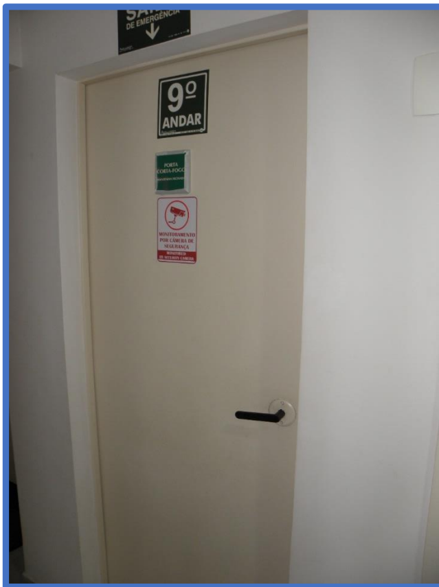
Foto: Escada de emergência.
