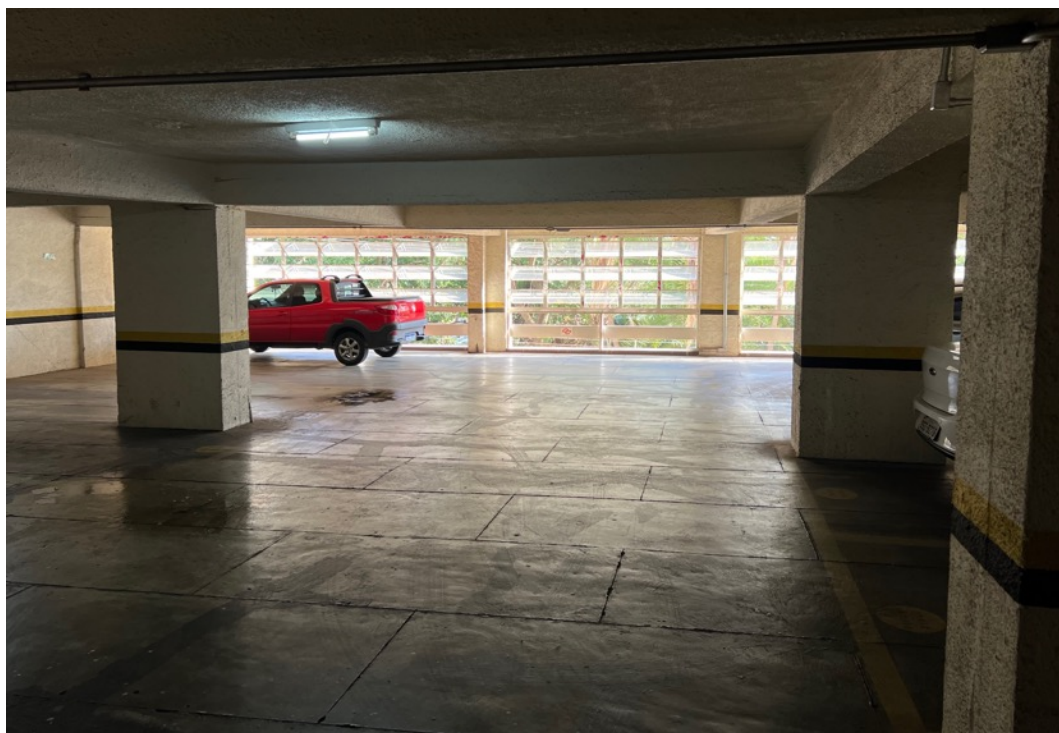
Imagem 11: Ambiente dos pavimentos de garagem do condomínio
