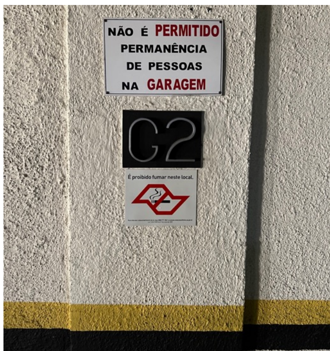
Imagem 10: Pavimento G2, onde o Box N° 43 está localizado
