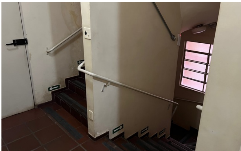
Imagem 07: Escadaria de acesso aos pavimentos do condomínio
