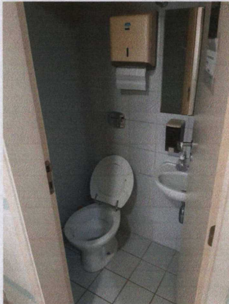
Aspecto de um dos banheiros.
