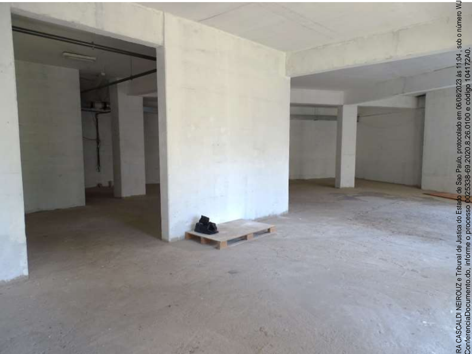
FOTO – 13 -VISTA INTERNA
