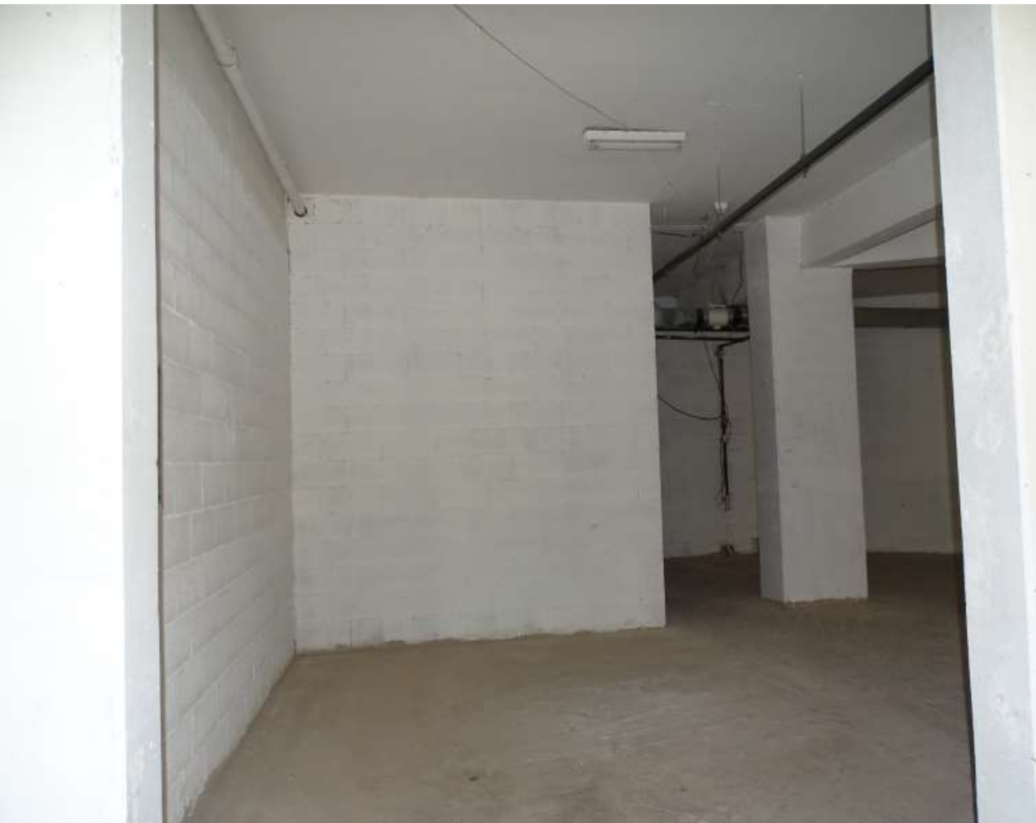
FOTO – 25 -VISTA INTERNA
