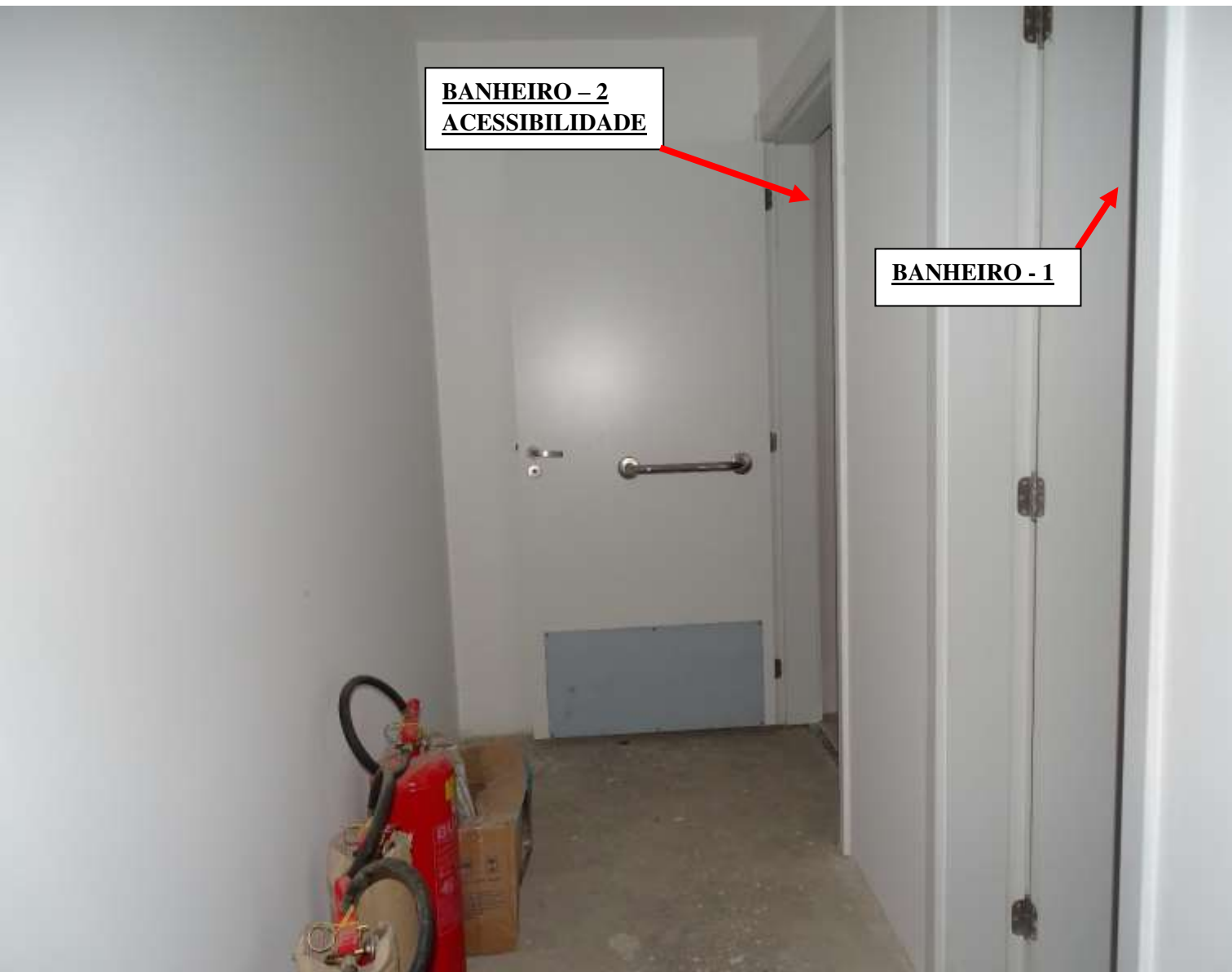
FOTO – 21 -VISTA INTERNA/ACESSO AOS BANHEIROS
