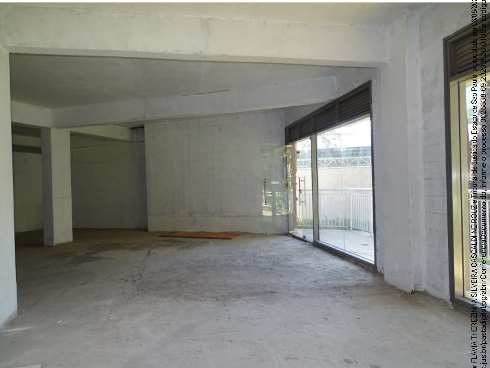
FOTO – 26 -VISTA INTERNA
