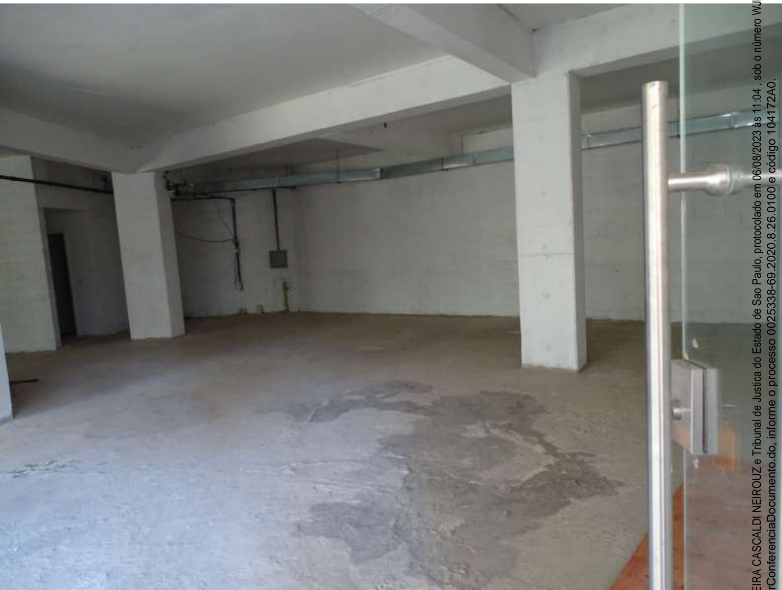
FOTO – 10-VISTA INTERNA
