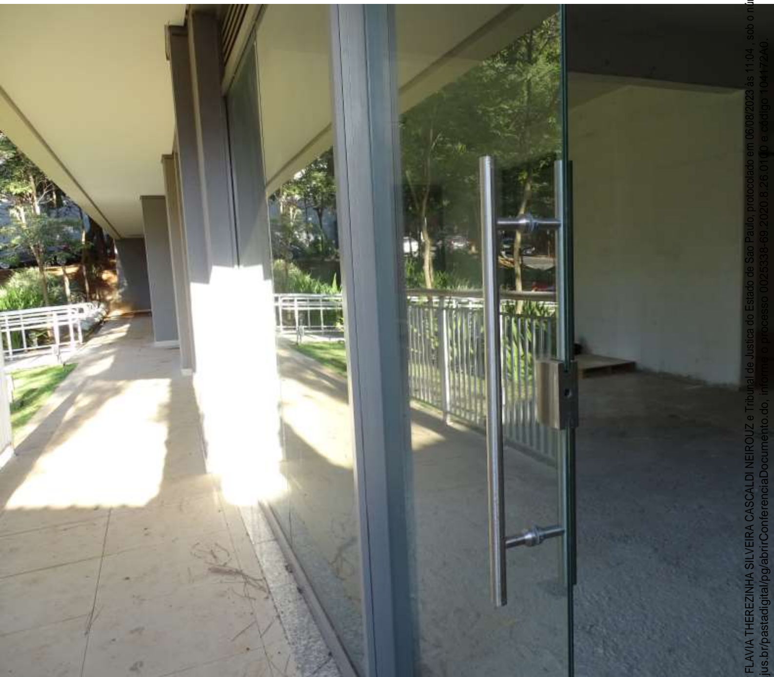
FOTO – 9- FACHADA DA LOJA – VISTA - 8
