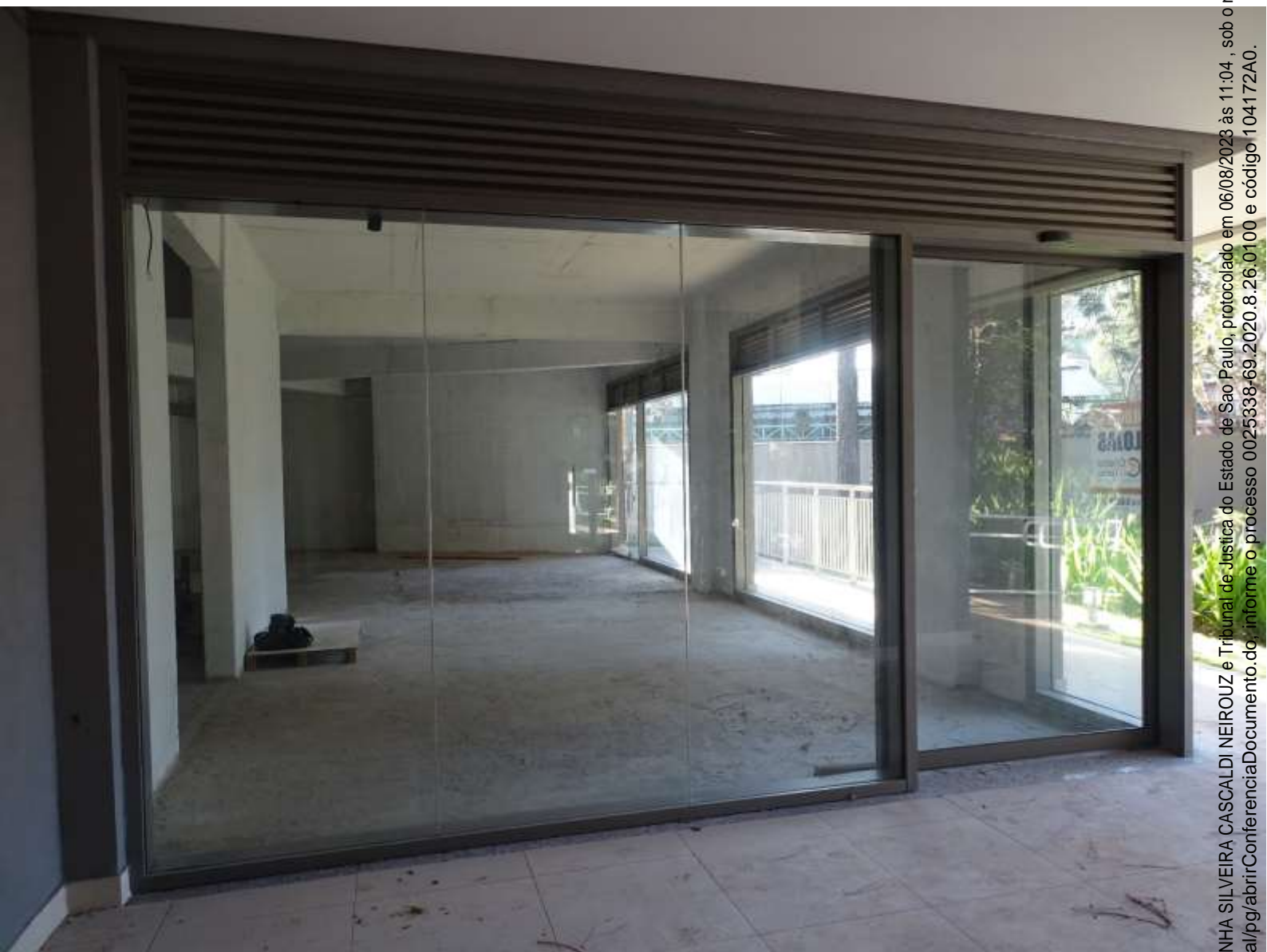
FOTO – 4- FACHADA DA LOJA – VISTA -3
