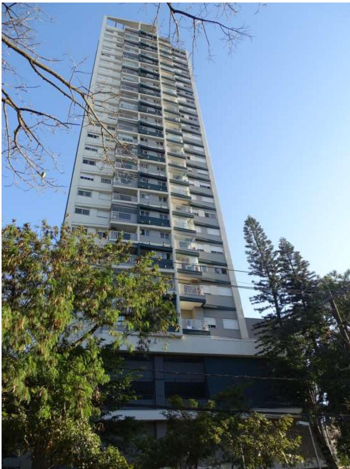
FOTO – 36 -VISTA EXTERNA/FACHADA
