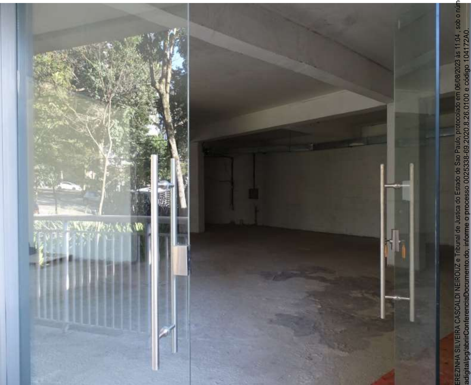
FOTO – 8- FACHADA DA LOJA – VISTA - 7
