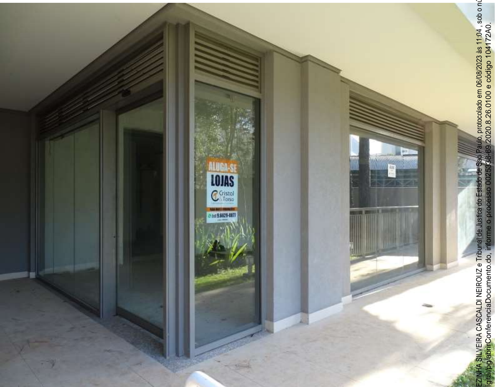
FOTO – 5- FACHADA DA LOJA – VISTA -4
