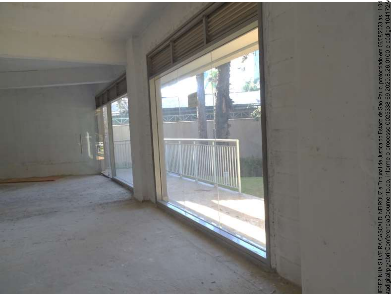
FOTO – 32 -VISTA INTERNA
