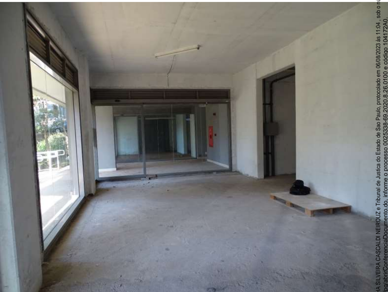
FOTO – 12-VISTA INTERNA
