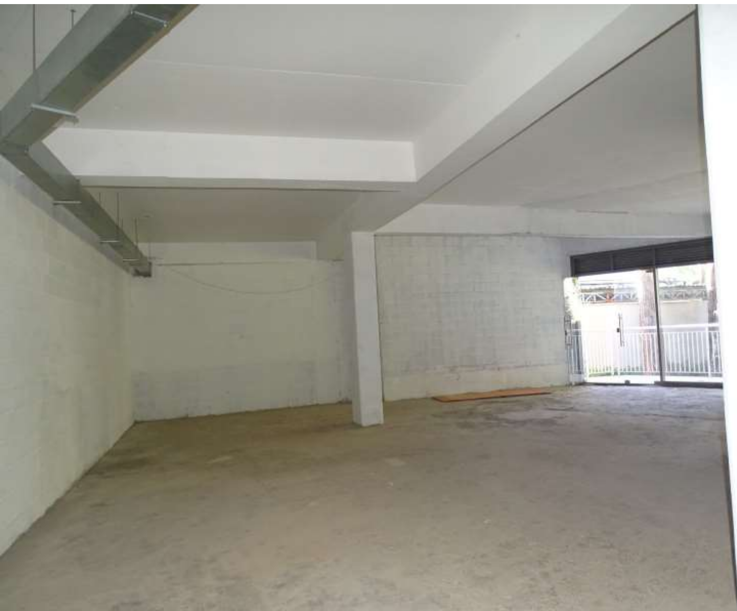
FOTO – 31 -VISTA INTERNA
