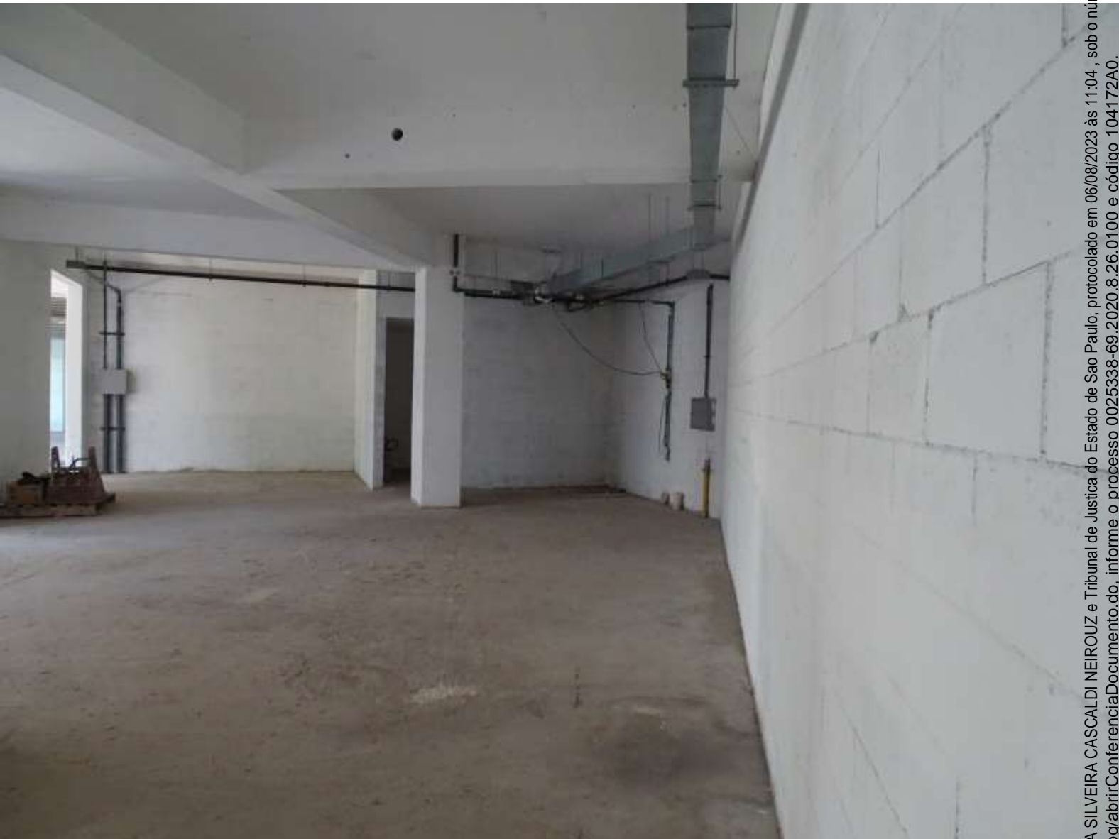
FOTO – 17 -VISTA INTERNA
