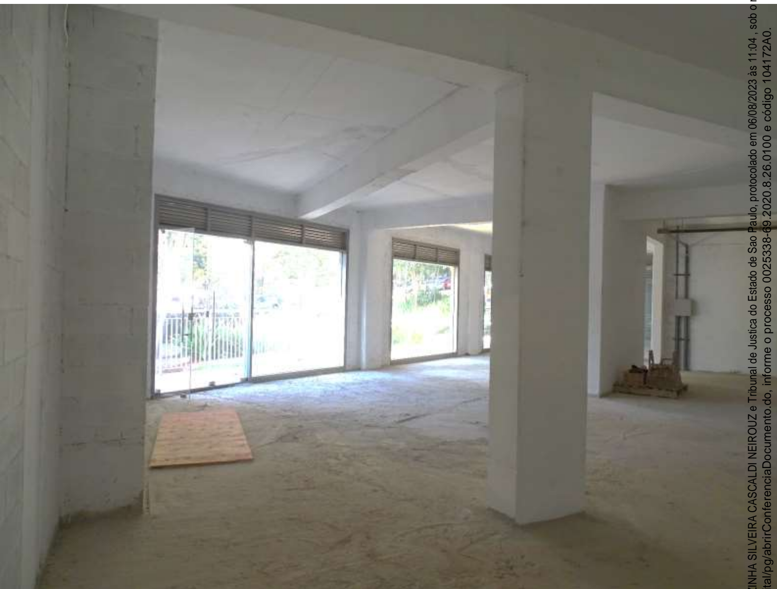
FOTO – 15 -VISTA INTERNA
