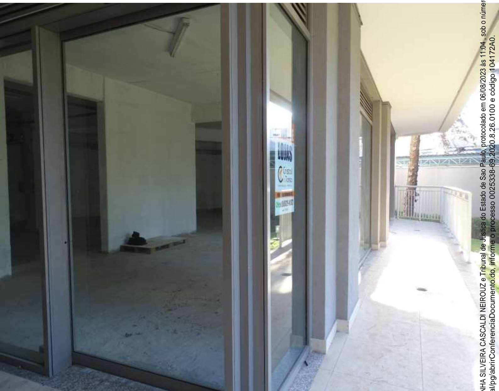
FOTO – 3- FACHADA DA LOJA – VISTA -2
