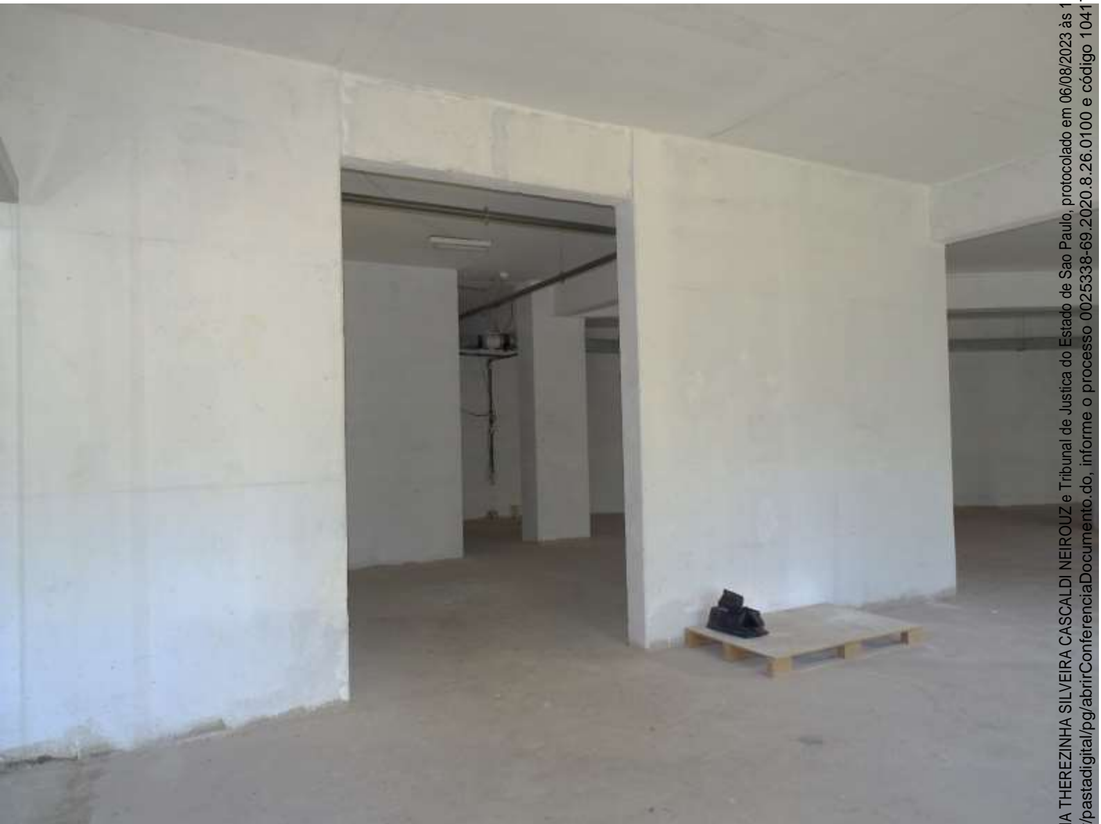
FOTO – 24 -VISTA INTERNA
