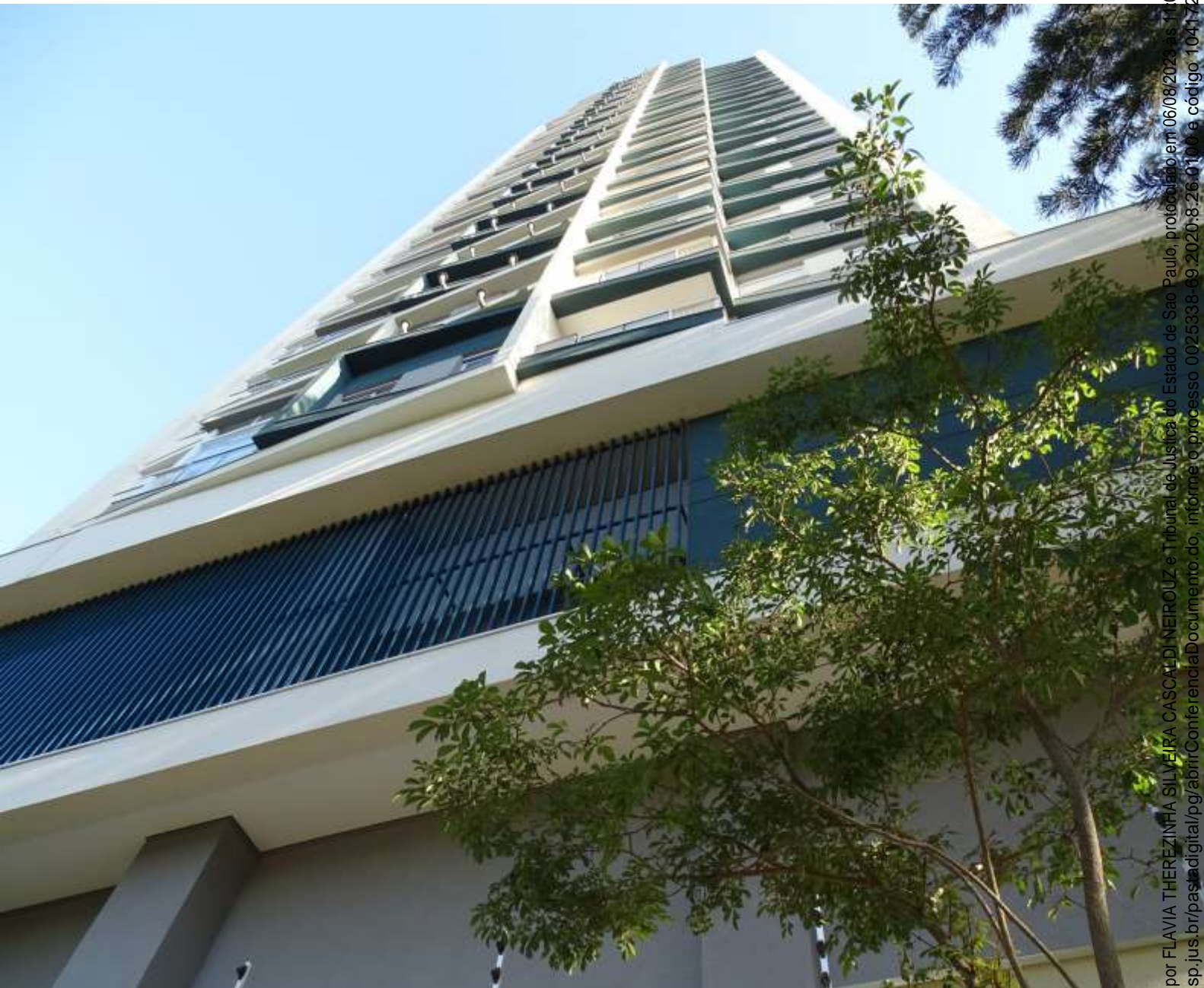
FOTO – 1- FACHADA DO PRÉDIO
