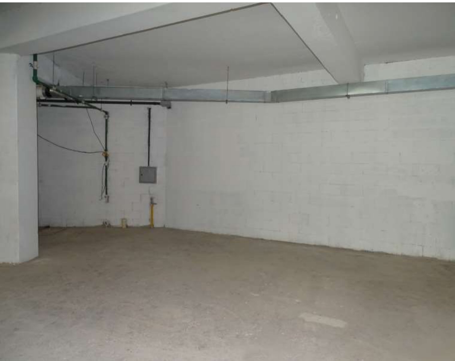
FOTO – 28 -VISTA INTERNA
