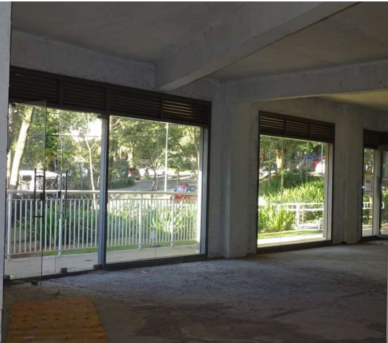
FOTO – 30 -VISTA INTERNA
