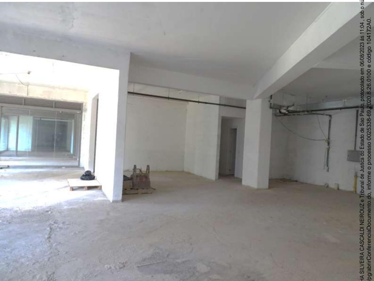
FOTO – 14 -VISTA INTERNA
