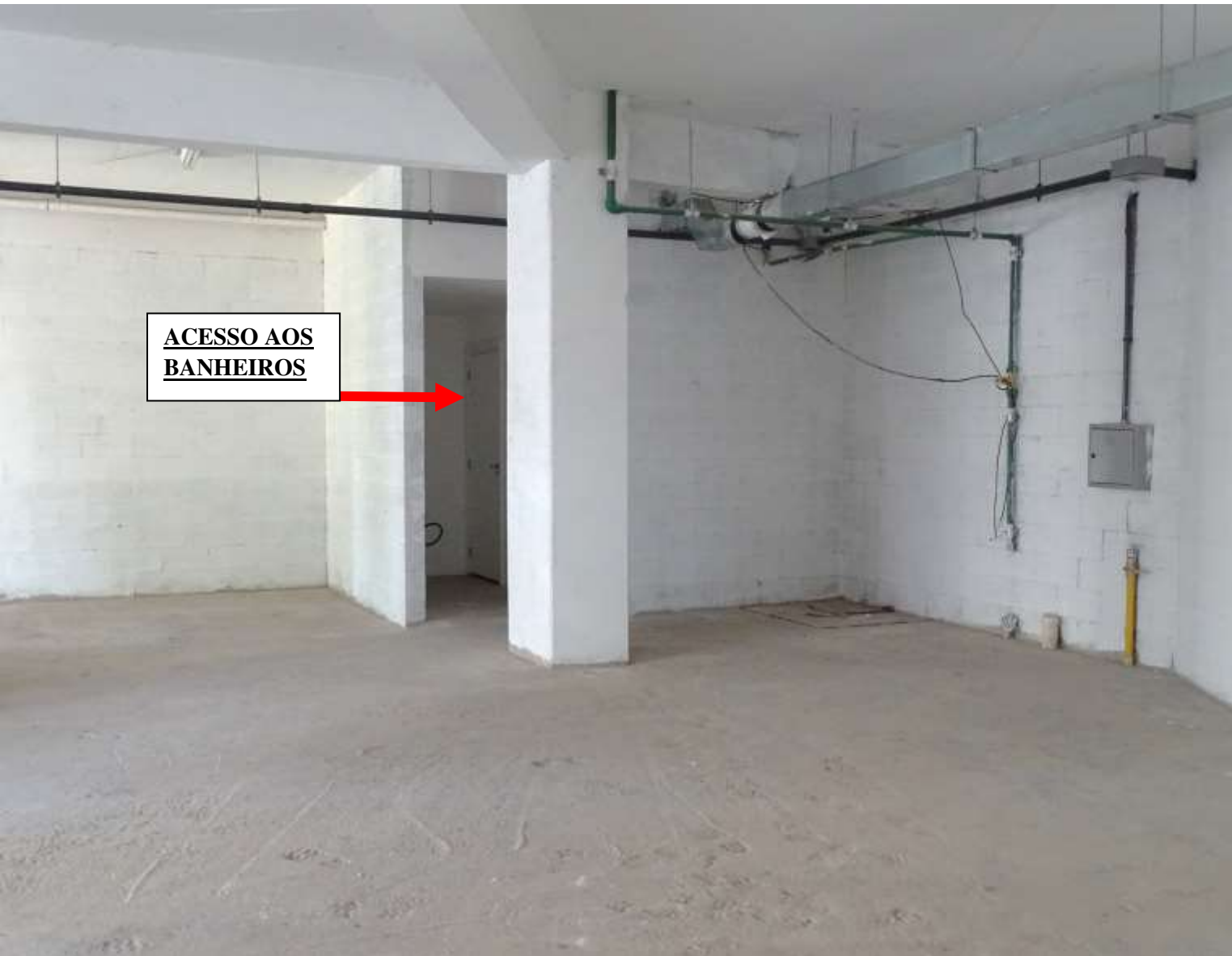
FOTO – 20 -VISTA INTERNA
