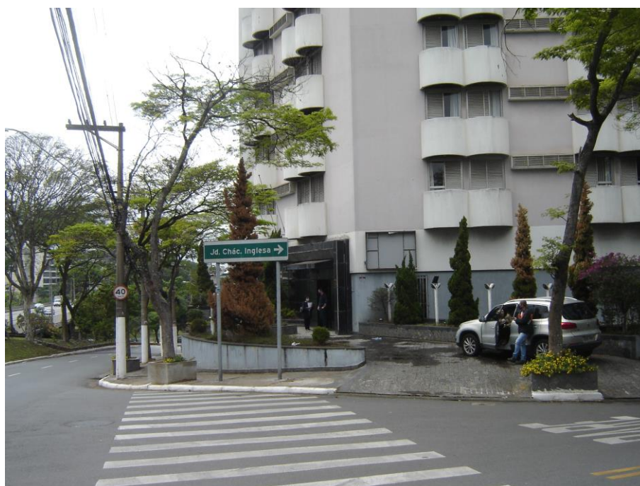
Vista lateral do edifício
