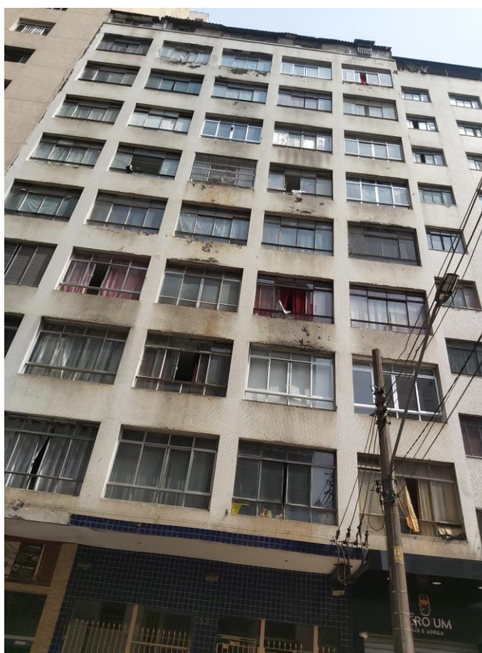
Vista do Edifício Castelinho
