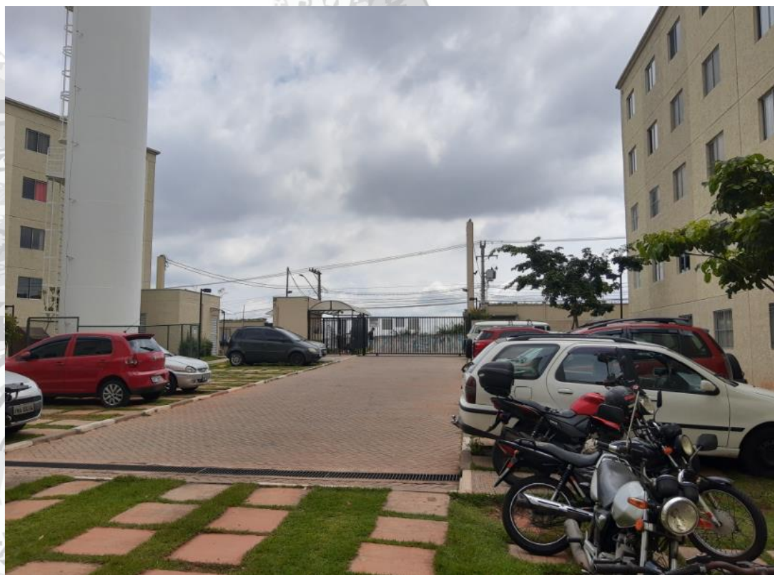
FOTO VISTA GERAL ÁREA EXTERNA
