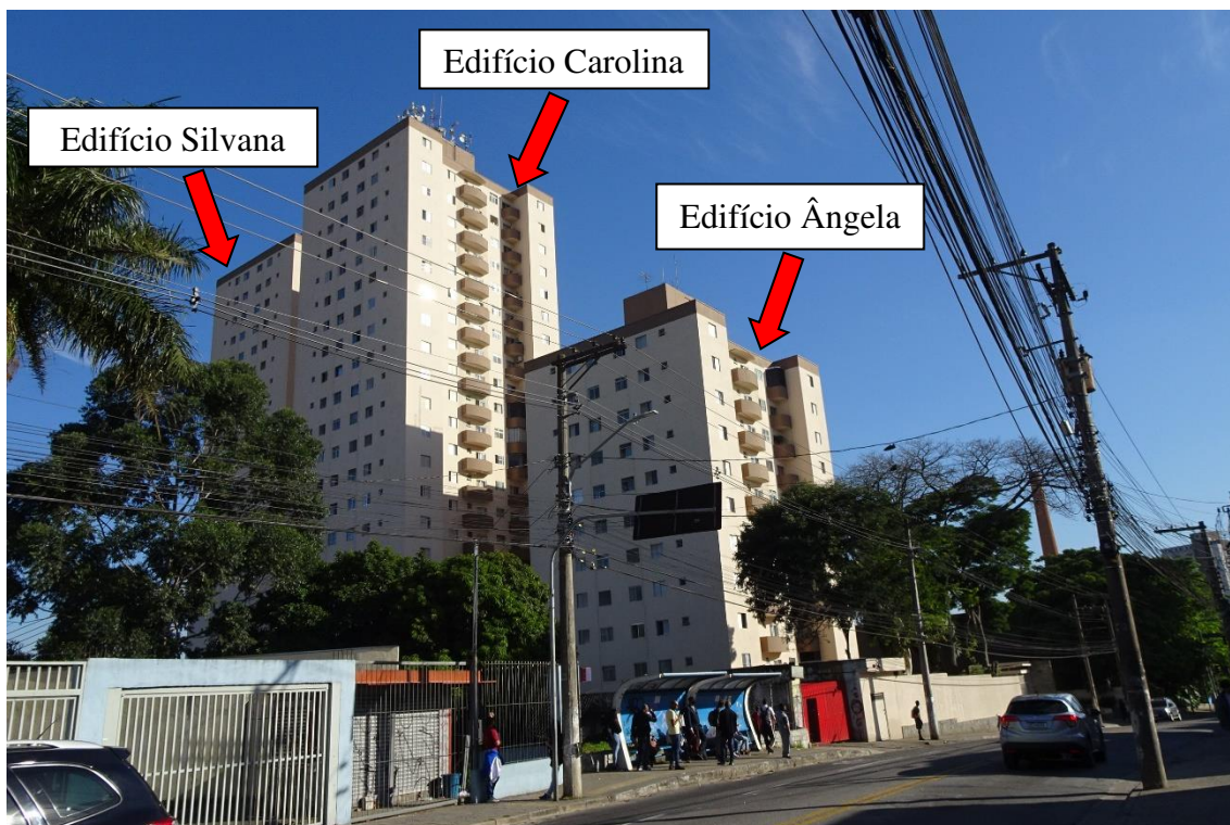
Foto 05: Vista lateral pela Avenida Monteiro Lobato do Conjunto Residencial Jardim San Remo e a fachada dos edifícios.
