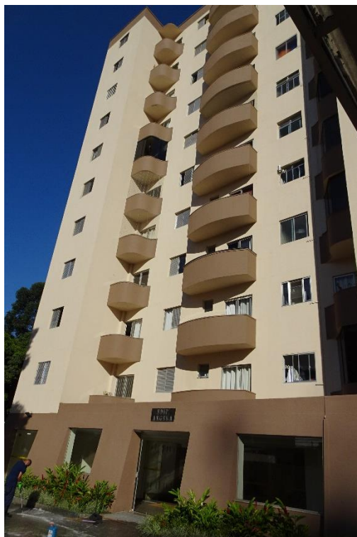
Foto 07: Vista da fachada do Edifício Ângela, Bloco A.
