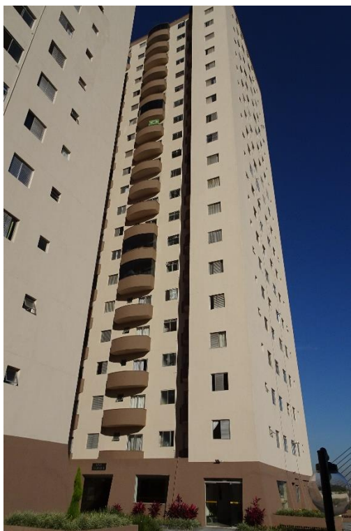
Foto 09: Vista da fachada do Edifício Silvana, Bloco C.
