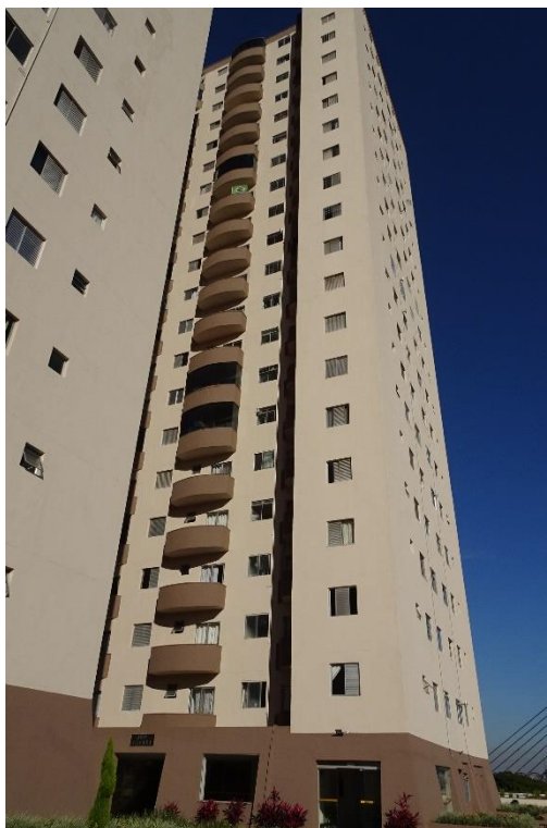
Foto 08: Vista da fachada do Edifício Carolina, Bloco B.
