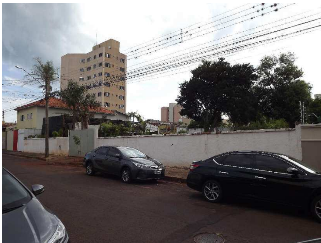
Imagem 8 - Vista posterior do imóvel avaliando
