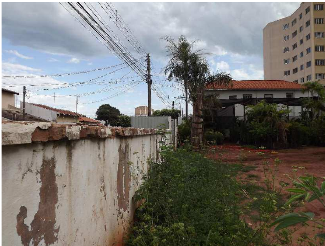
Imagem 14 – Limite da divisa frontal, visto pelo lado interno do imóvel
