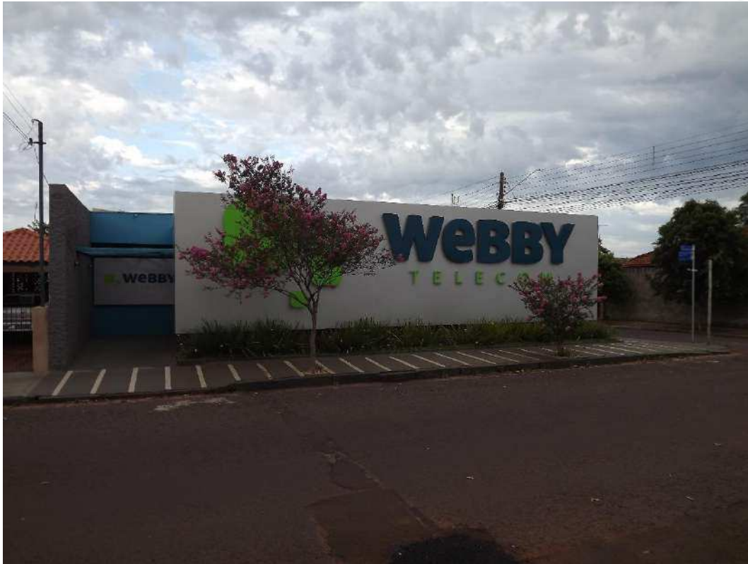
Imagem 21 - Empreendimento comercial na rua Quintino Bocaiuva
