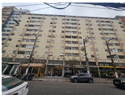
FACHADA DO PRÉDIO
