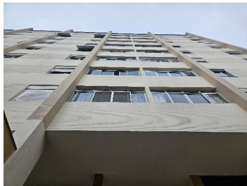
Vista dos Fundos do Prédio
