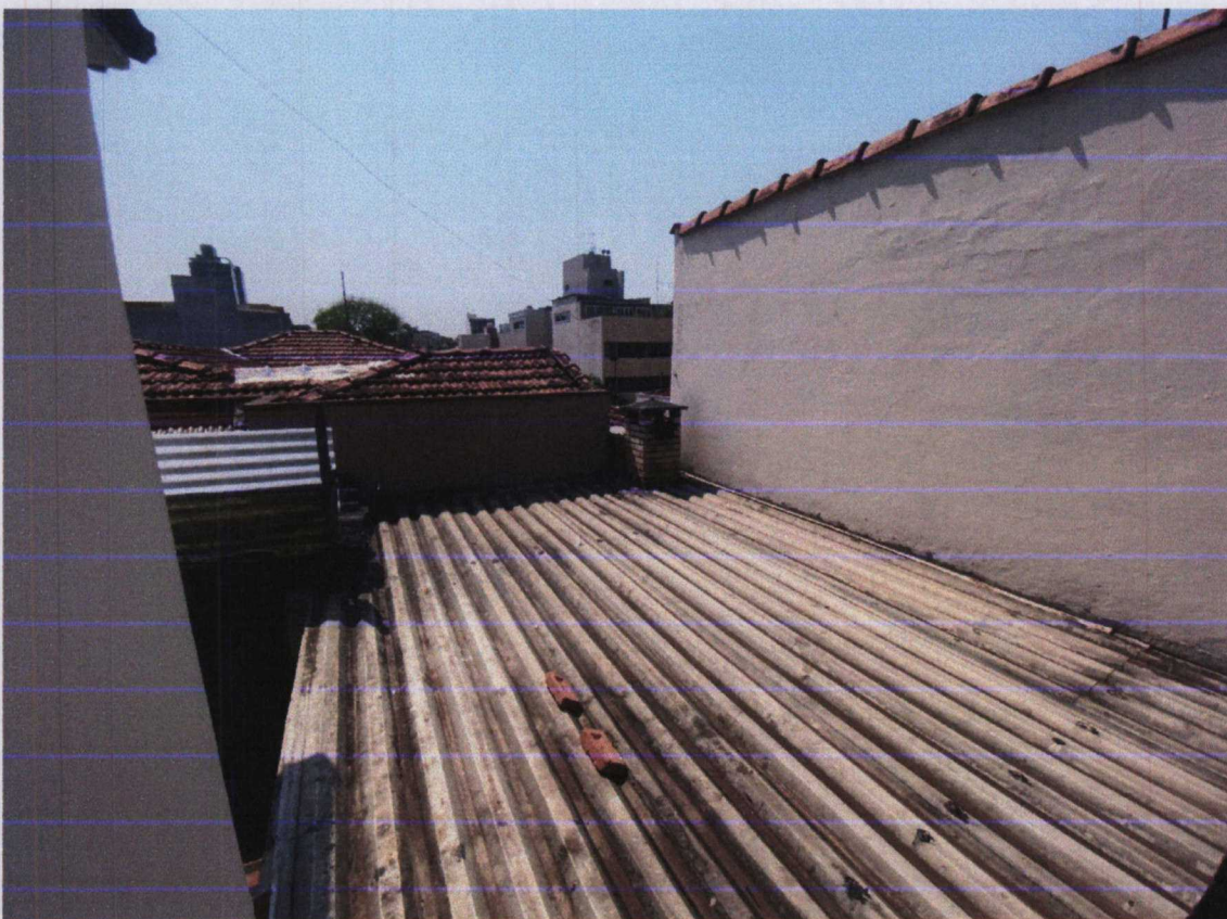
Foto 18: Vista do telhado da garagem.
