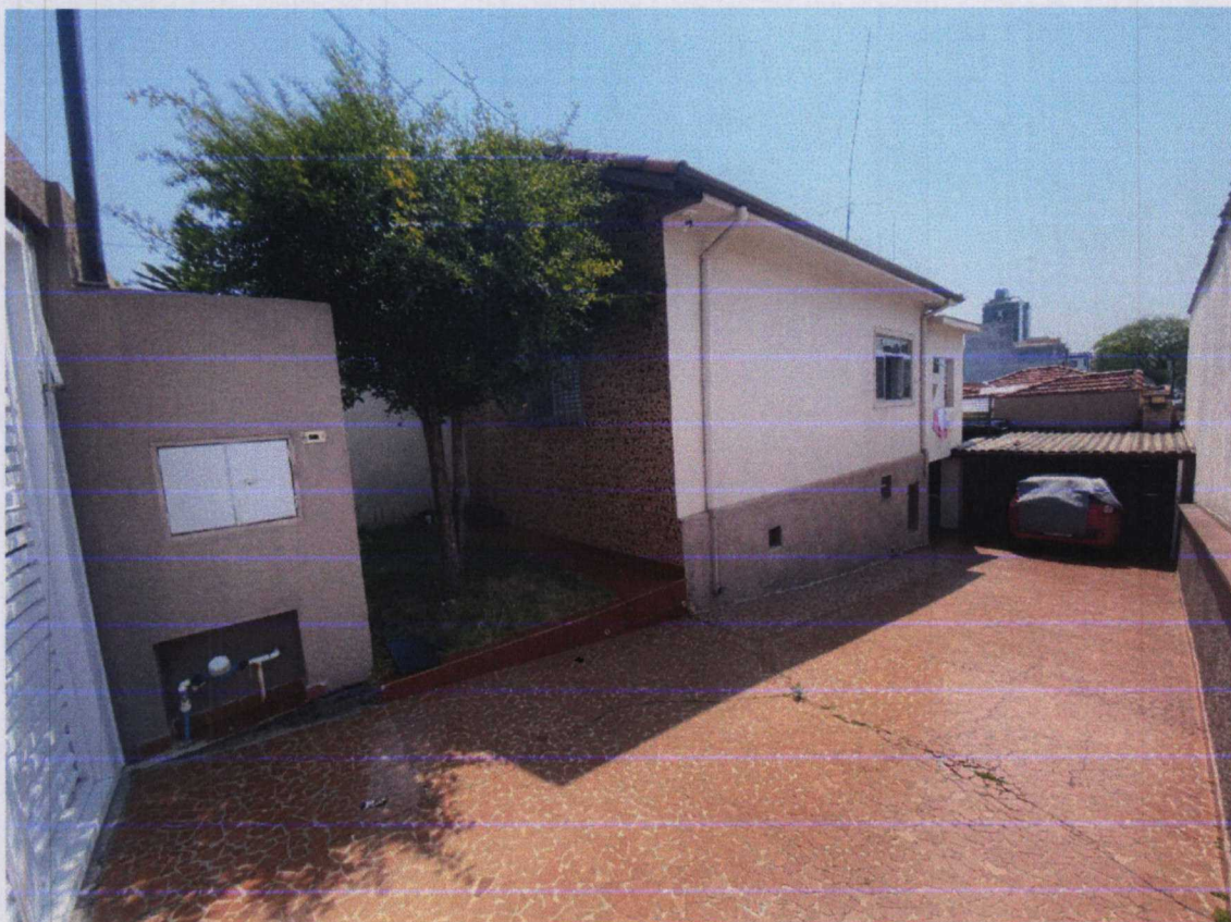
Foto 04: Vista geral da casa desde portão de entrada.
