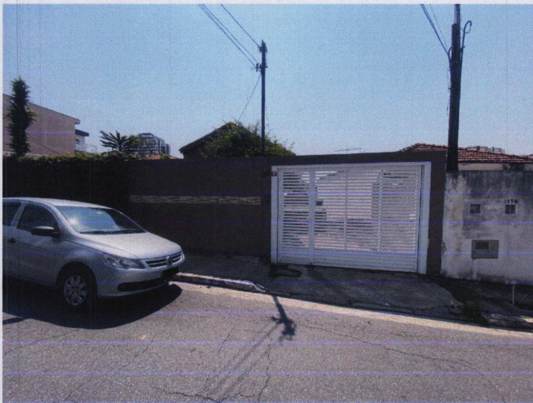
Foto 01: Vista do muro e portão desde Rua Flávio Fongaro.
