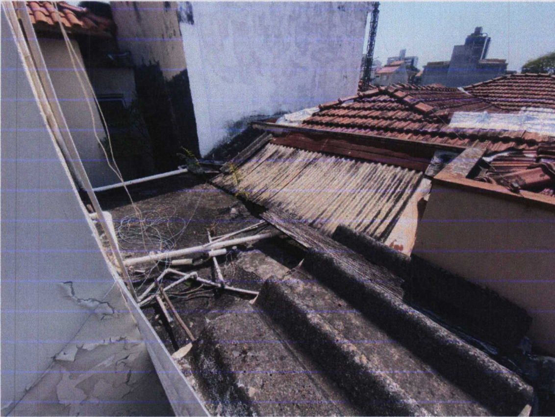
Foto 19: Vista do telhado do piso inferior nos fundos.
