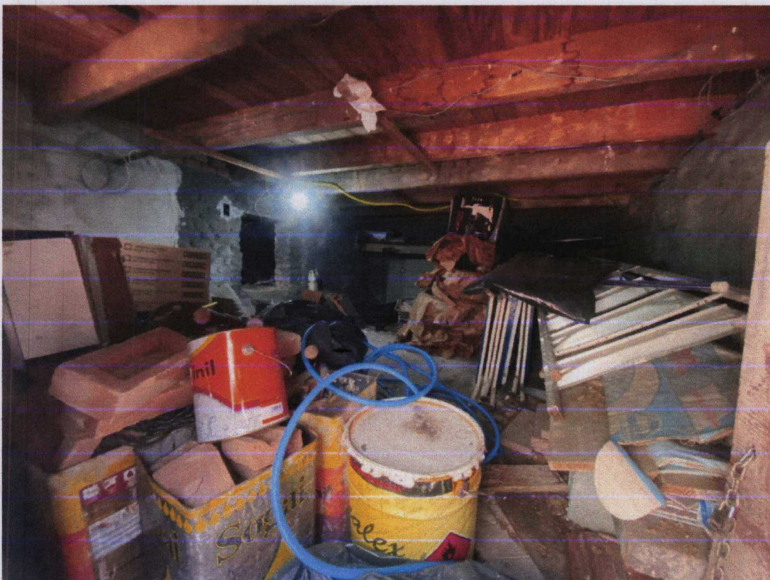
Foto 23: Vista do porão abaixo da sala.
