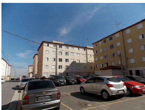
Foto 5 – Aspecto geral do interior do Condomínio Residencial Brisas.
