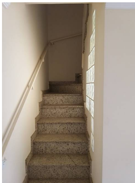
Foto 34: Escadaria de acesso ao pavimento superior
