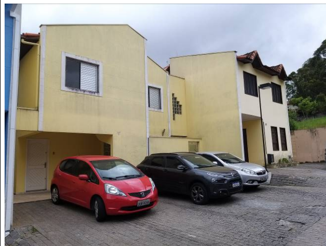
Foto 18: Vista geral das fachadas dos imóveis avaliados, que são vizinhos
