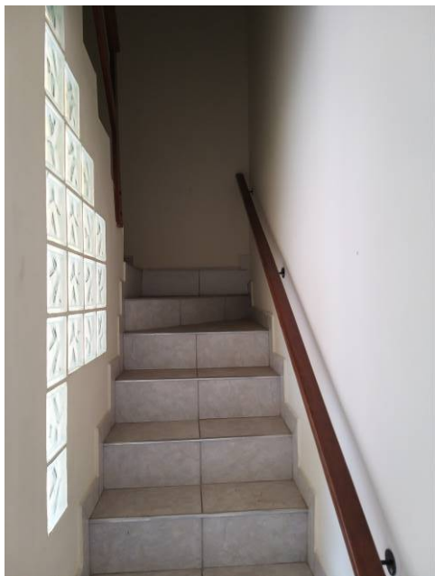
Foto 59: Escadaria de acesso ao pavimento superior
