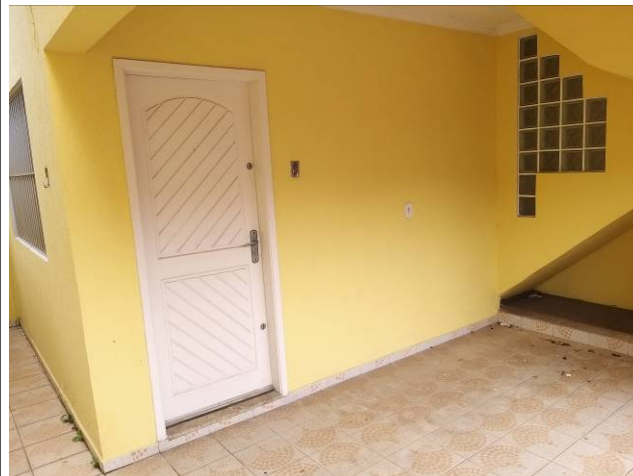
Foto 24: Hall de entrada da edificação
