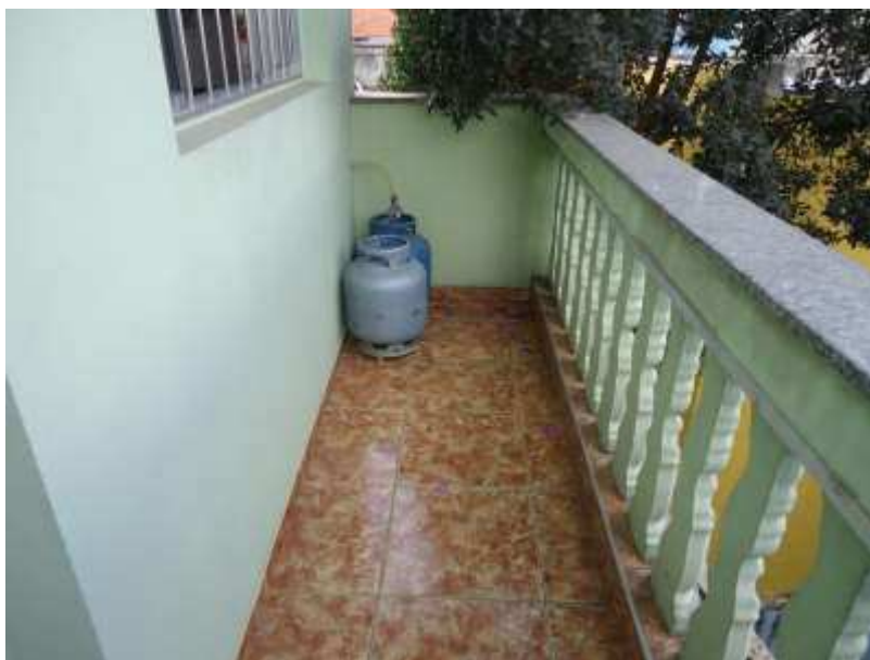
Foto 17- Detalhe interno da edificação – Pav. Inferior – Sacada
