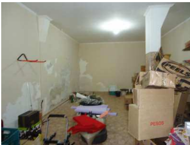
Foto 20 - Detalhe interno da edificação – Subsolo – Salão
