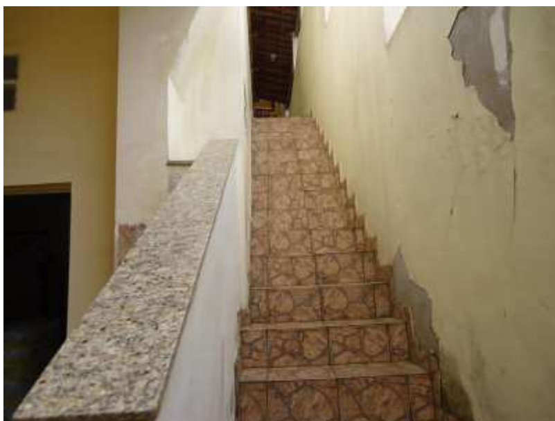
Foto 18 - Detalhe externo da edificação – Escada do Pav. Inferior p/ Subsolo
