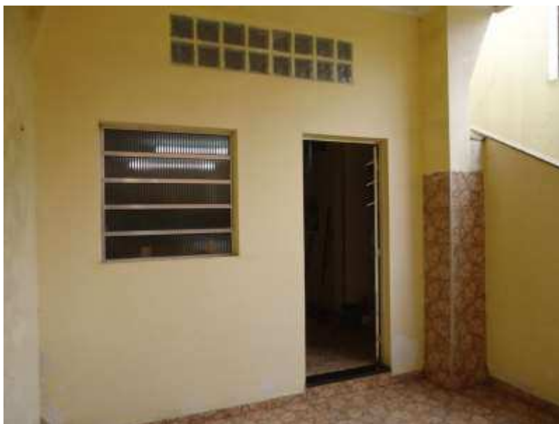
Foto 19- Detalhe externo da edificação – Subsolo – Fachada do salão
