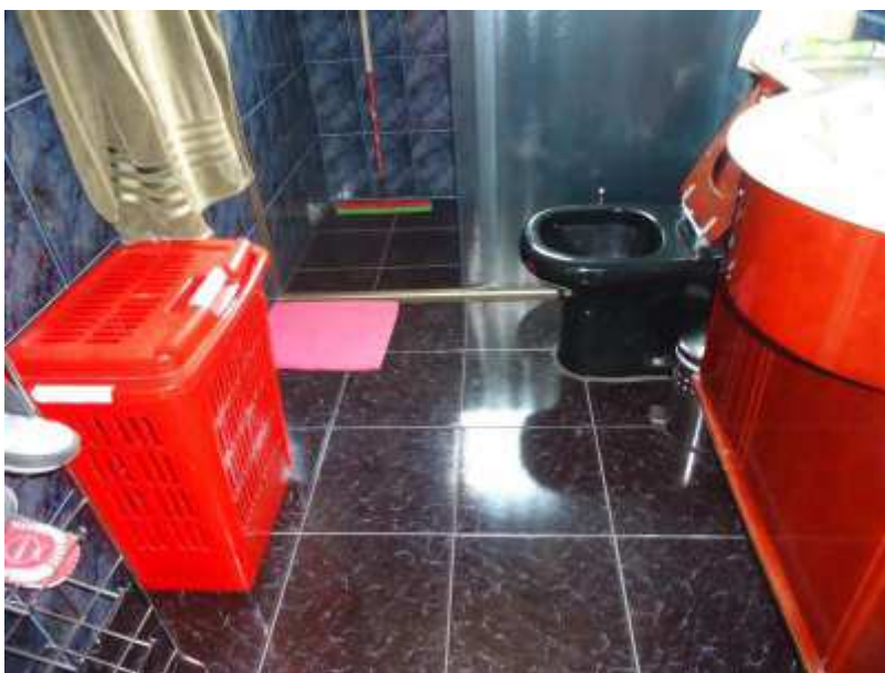
Foto 08- Detalhe interno da edificação – Pav. Térreo – Banho-Suíte
