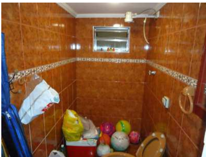
Foto 21 – Detalhe interno da edificação Subsolo – Banho
