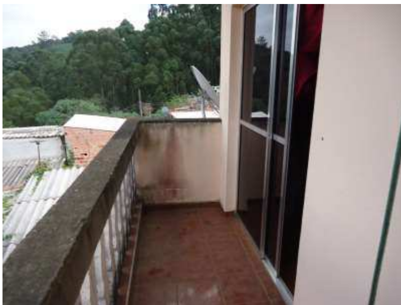
Foto 10- Detalhe externo da edificação – Pav. Térreo – Sacada
