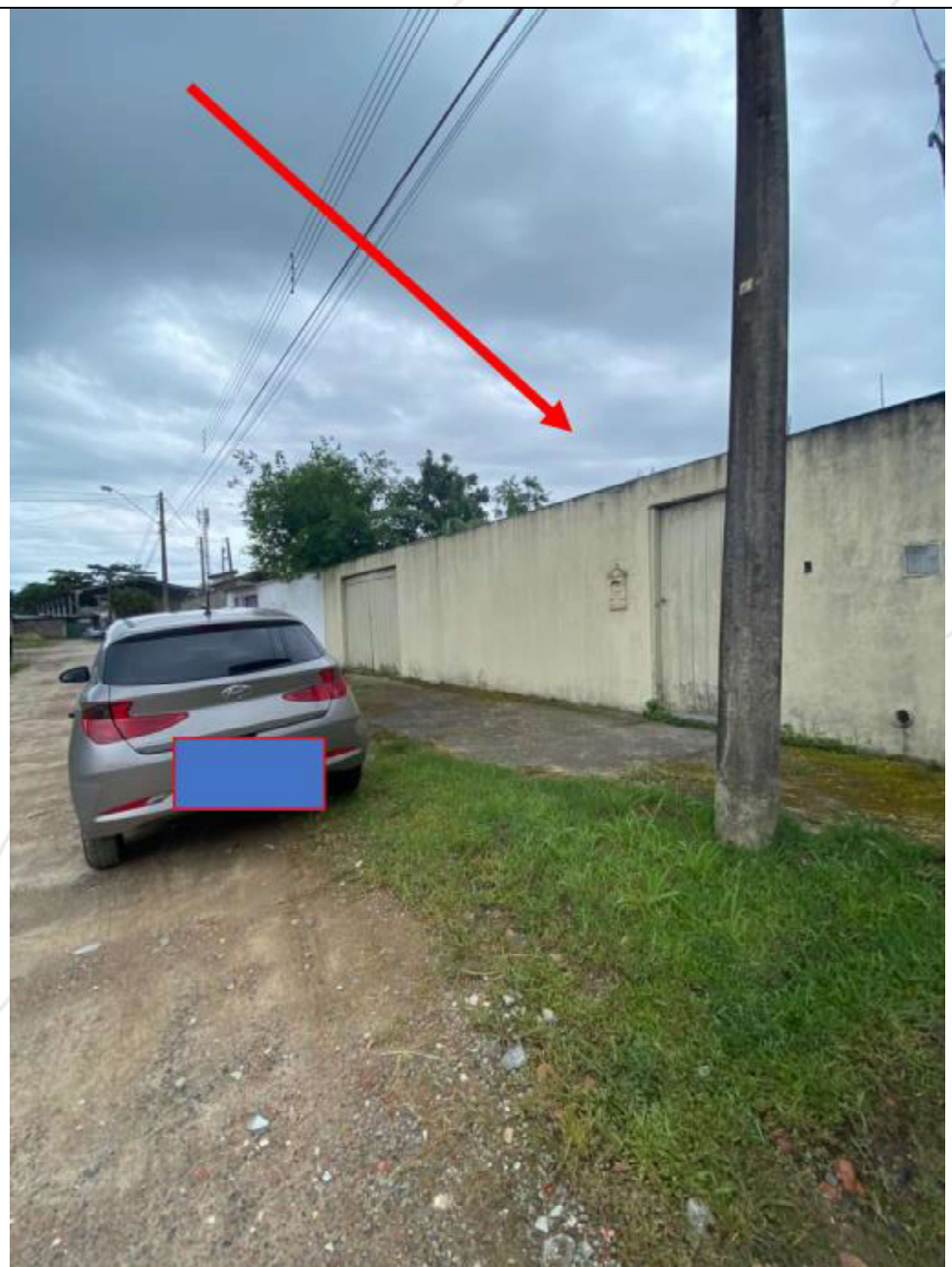
FOTOGRAFIA 02 – VISTA GERAL DA FACHADA DO IMÓVEL DESTE PRESENTE TRABALHO.
