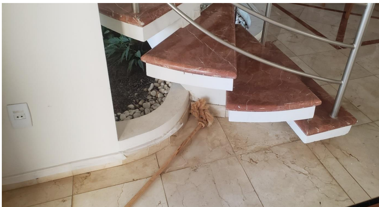
Detalhes da Escada
