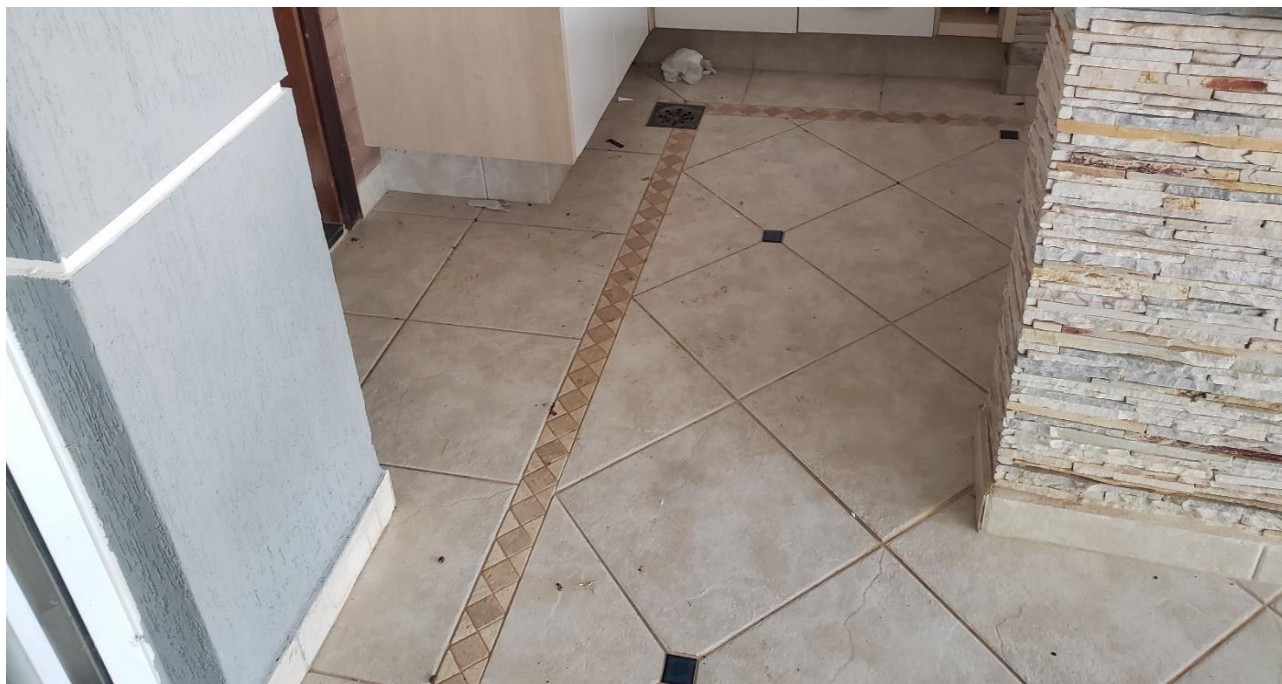
Detalhes do Piso Externo
