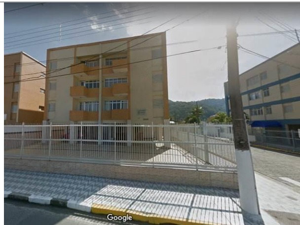
Frente do Edifício
