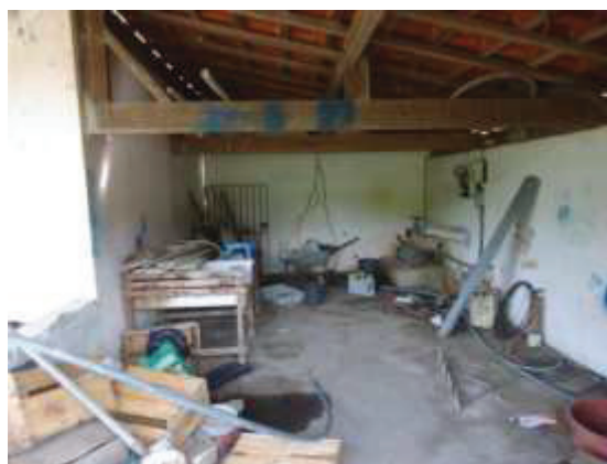
22. Vista interna do depósito
