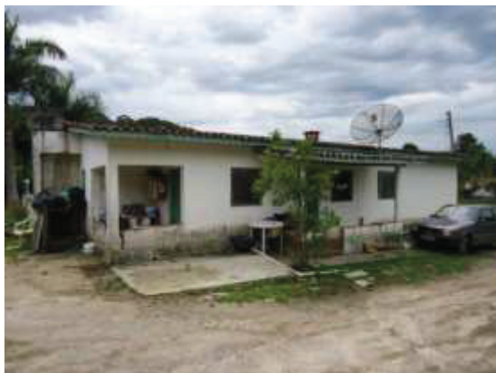
03. Fachada – casa do caseiro
