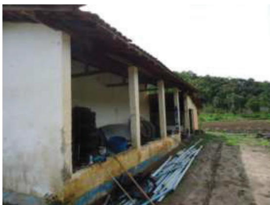
21. Vista interna do depósito
