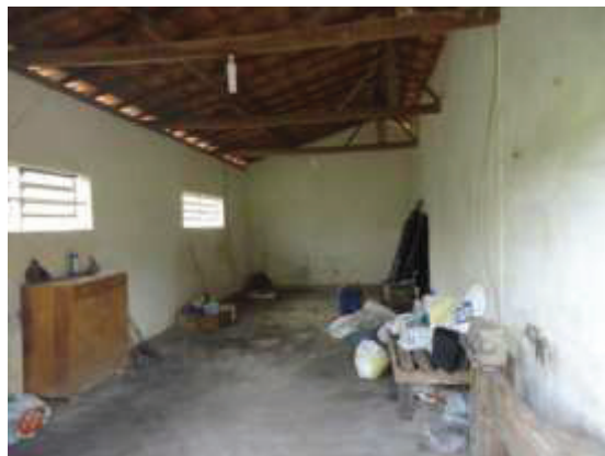
20. Vista interna do depósito
