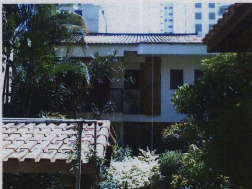
Fachada dos fundos
