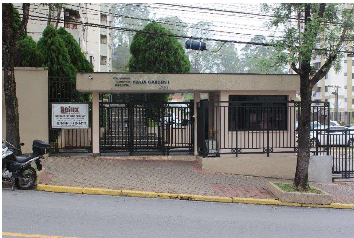
Conjunto Residencial Yrajá Garden I – Fachada
