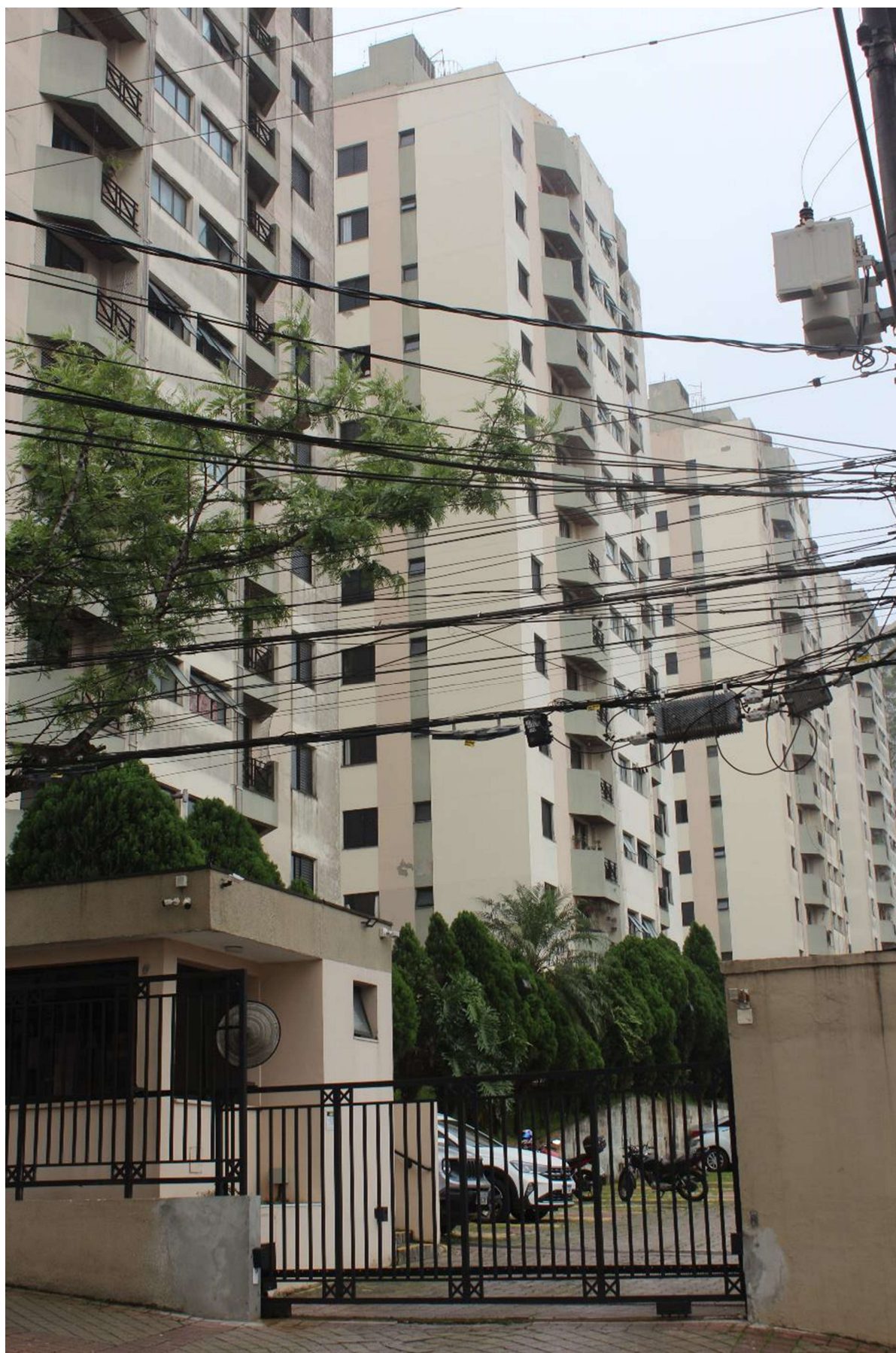
Conjunto Residencial Yrajá Garden I – Fachada
