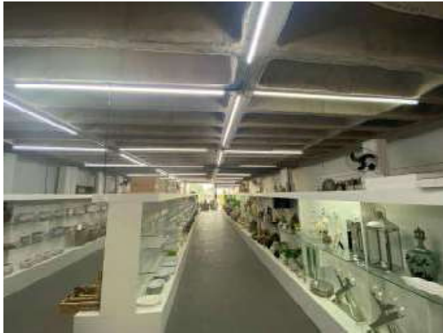
VISTA DO IMÓVEL.
