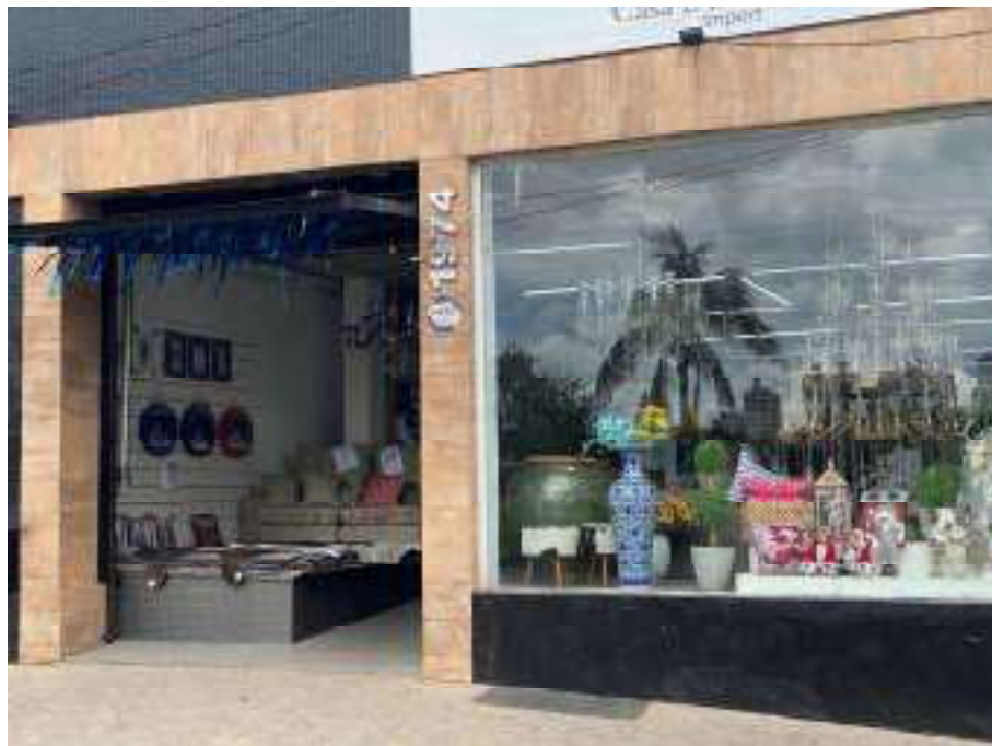
VISTA DA ENTRADA DO IMÓVEL.
