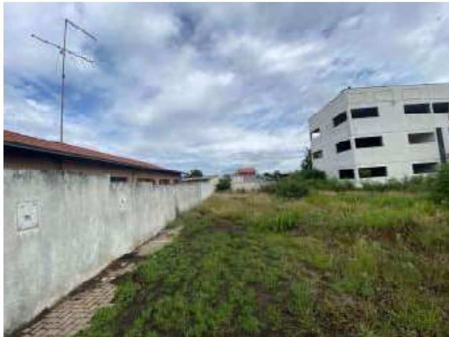
VISTA DO IMÓVEL.
