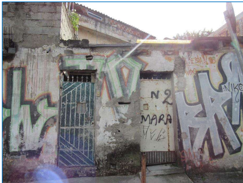
ASPECTOS GERAIS DO IMÓVEL.
