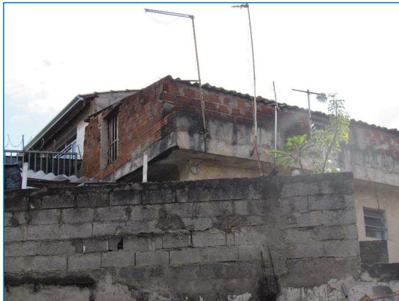
ASPECTOS GERAIS DO IMÓVEL.
