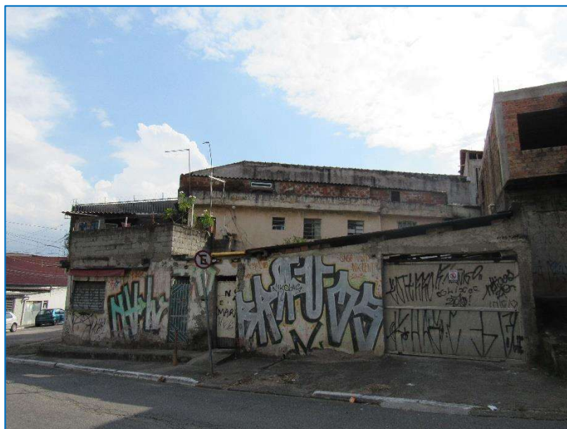
FACHADA DO IMÓVEL, PELA RUA SEIXAS.
