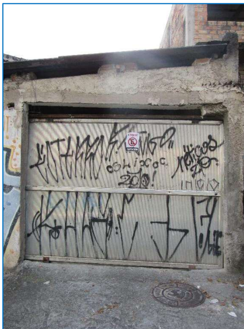
ASPECTOS GERAIS DO IMÓVEL.
