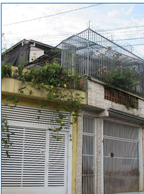
ASPECTOS GERAIS DO IMÓVEL.
