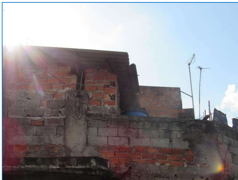
ASPECTOS GERAIS DO IMÓVEL.
