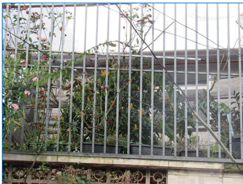
ASPECTOS GERAIS DO IMÓVEL.
